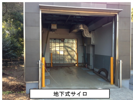
図 4.3-10 地下サイロの入口部
