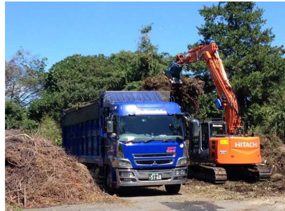
図 3.3-13 木質バイオマス処理（運搬）作業
