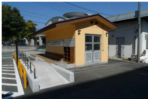
ボイラー室（建物左横が足湯）
