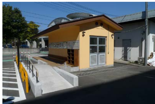
ボイラー室（建物左横が足湯）
