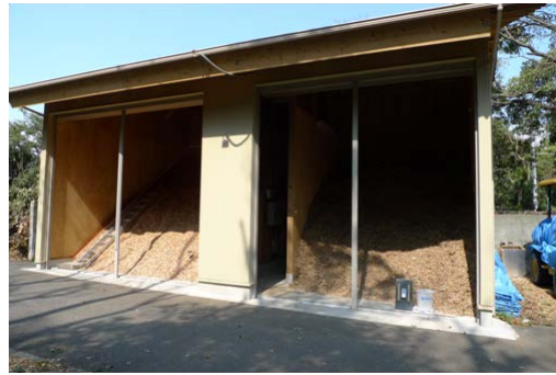
チップ乾燥施設（ソーラードライシステム）
