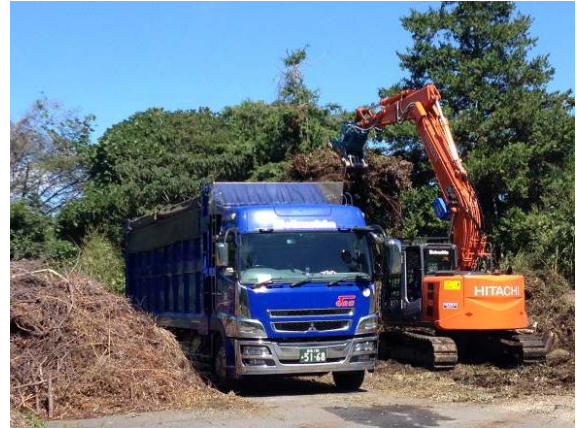
図 3.3-13 木質バイオマス処理（運搬）作業
