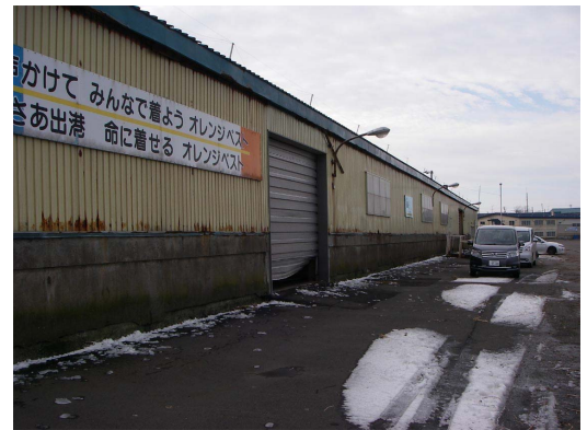
(1) 根室水産物卸売市場の建屋外観，海側からみた状況
