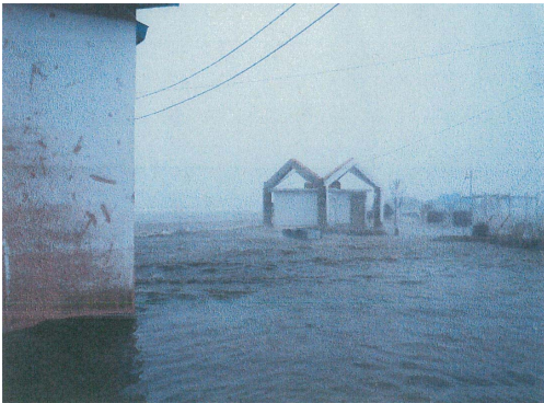
(3) 漁港内建物の浸水位置
