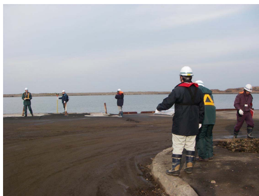
(2) 背後市街地の縦断形状の測定 (その1)
