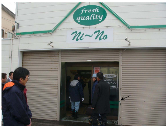
写真-付.F.1 緑町の浸水痕跡（矢印位置）
