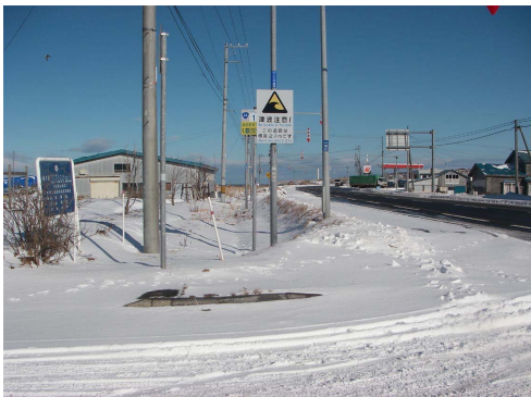
写真-4.38 写真4-37(2)と同じ地点を撮影した写真 (平成27年1月9日撮影)
