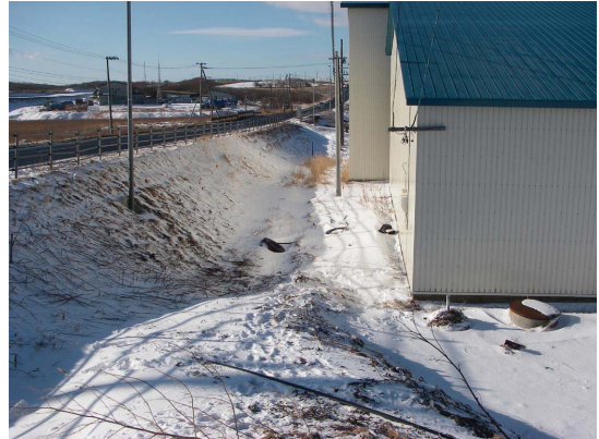
写真-4.33 浸水限界と推定した斜面 (地点4-dから南西方向を見た状況)
