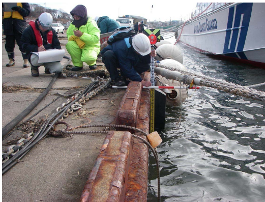
(1) 岸壁天端の高さの測定
