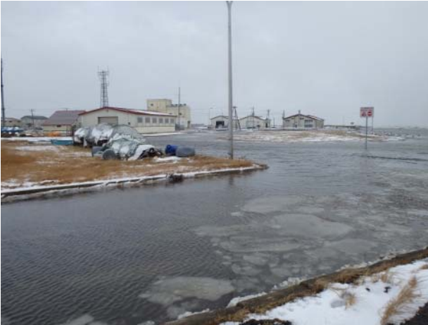
写真-2.6 別海町本別海地区における道路の浸水状況 (提供：別海町)
