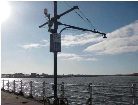
(1) 空中発射型超音波式潮位計
