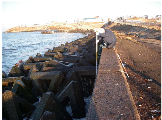
写真-4. 20 護岸パラペットの天端高さの測定（地点3-a）
