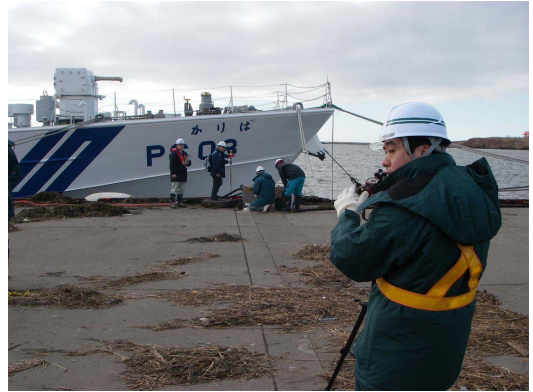
(2) エプロンの縦断形状の測定
