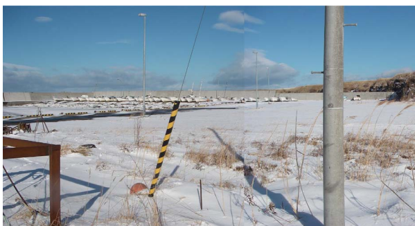
写真-4.36 防波堤に囲まれた船揚場・作業ヤード (地点5-cから北東方向を見た状況)
