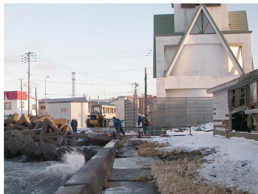
(2) ポンプ場 (右側のコンクリート造建物)
