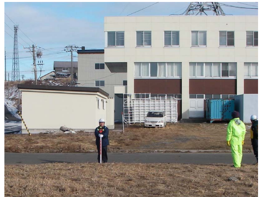
(3) 海側から陸側を見た状況
