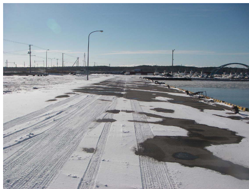
写真-4.40 平坦な漁港敷地 (地点6-bから南方向を見た状況)
