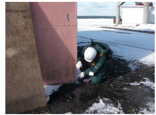
(3) 浸水高の測定 (調査員が指差す位置)
