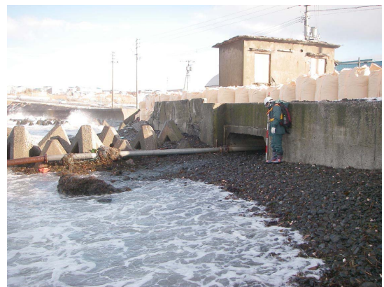
写真-4. 21 小規模な水路の海側開口部（地点3-b）
