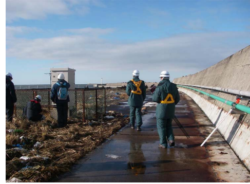
写真-4.2 潮位計データ収録装置 (左側の矩形箱, 地点1-b)
