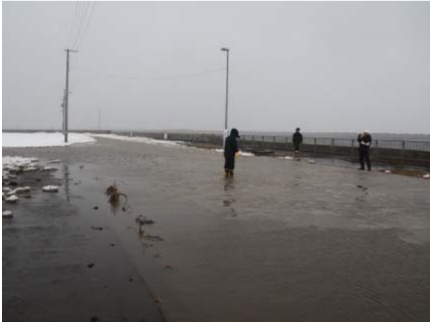
写真-2.11 網走港新港地区における道路の浸水状況 (提供：網走市)
