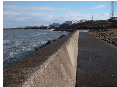
写真-4.3 北浜地区護岸 (地点1-cから東側を見た状況)
