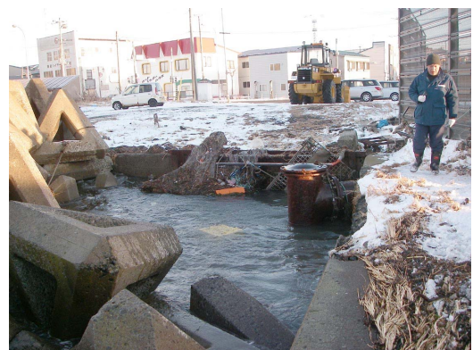
(1) 暗渠の海側開口部 (調査員の近くの円筒形構造物の奥側)
