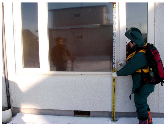
写真-4.25 地盤からの痕跡高さの測定 (地点3-e)
