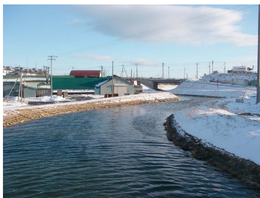
(2) 歩行者用橋梁から上流側を見た状況
