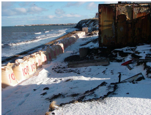
写真-4.32 応急的な対策が実施された海岸線 (地点4-c)
