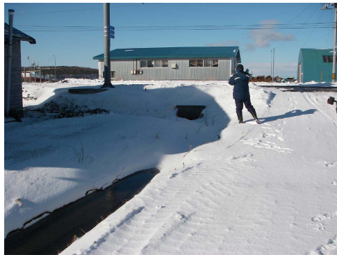
(2) 浸水経路と考えられる小規模な水路 (写真左下から調査員左側を通る水路)
