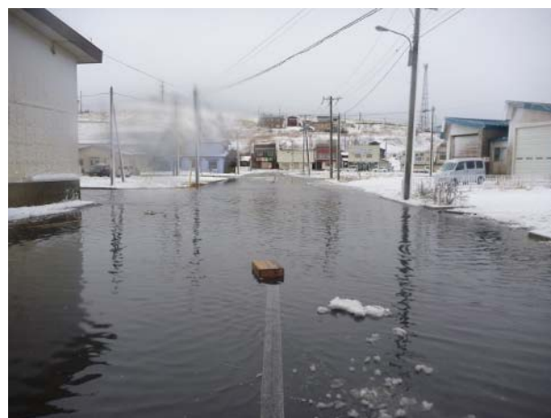
写真-2.1 根室港花咲港区における道路の浸水状況 (提供: 根室港湾事務所)
