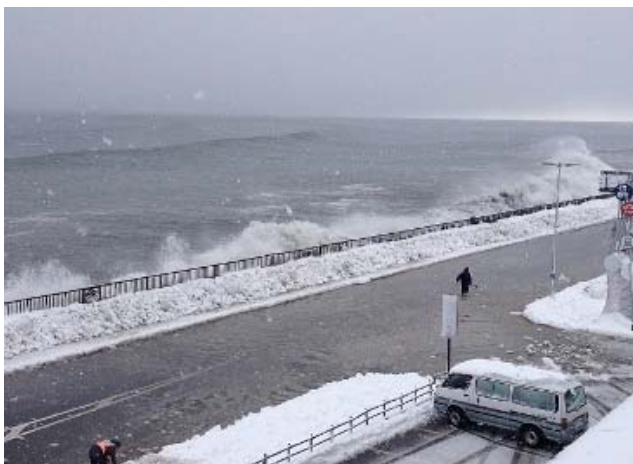
写真-2.9 羅臼町における越波による道路の浸水状況 (提供：羅臼町)
