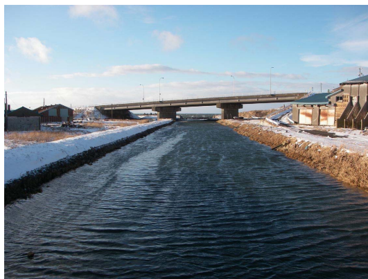
(1) 歩行者用橋梁から下流側を見た状況
