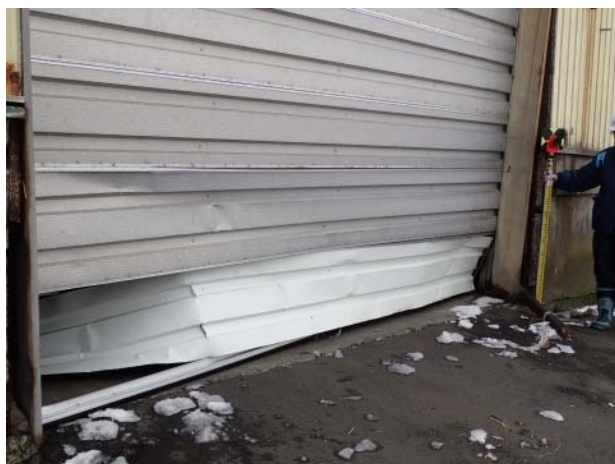
写真-2.5 根室港根室港区におけるシャッター損壊状況 (提供：根室港湾事務所)
