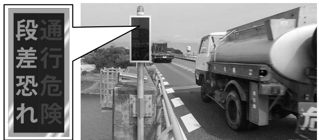
図-4 標示板設置事例
