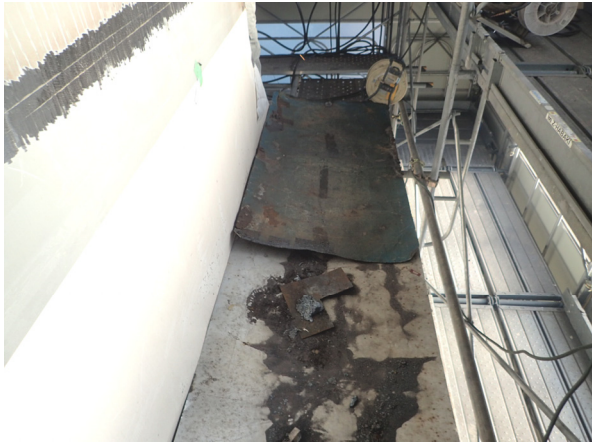
写真-4.3.7 溶接時の局所養生
