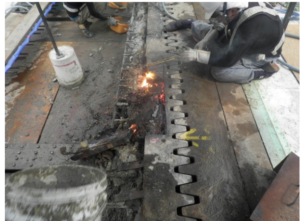
写真-5.3.4 伸縮装置の撤去（溶断）
