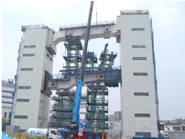
写真-4.3.6 橋脚の風防設備の例
