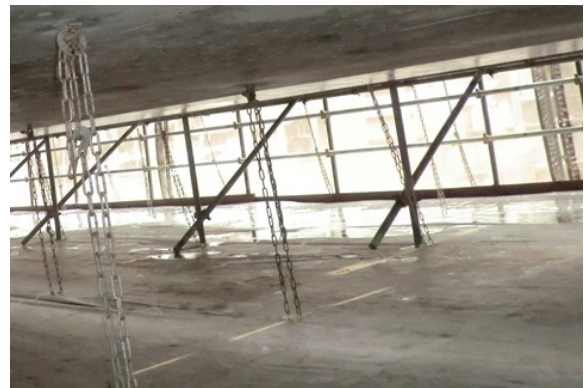
(b) 吊り足場（内部：シート張防護）
