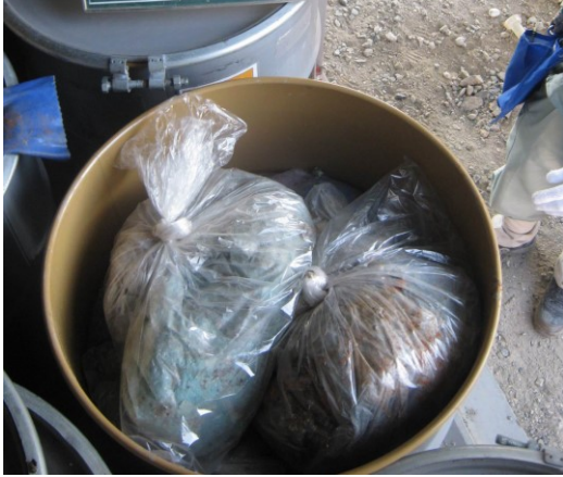
写真-4.1.2 除去された塗膜の収集・運搬状況
