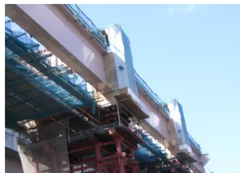
写真-3.3.10 現場溶接部風防の例
