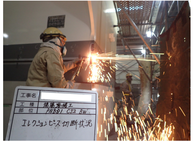
写真-4.3.8 溶断時の局所養生
