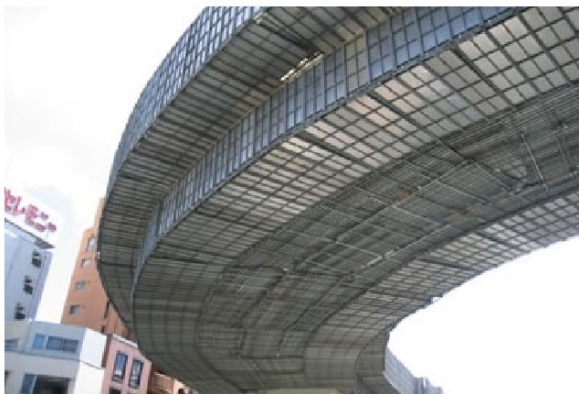
(a) 吊り足場（外観）
