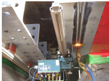
写真-4.2.2 自動ガス切断の例
