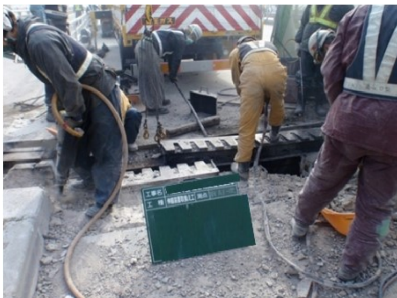
写真-4.1.4 伸縮装置撤去状況
