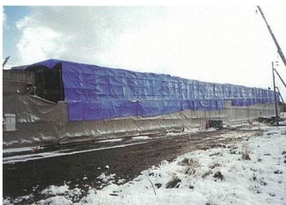
写真-5.2.1 冬季養生用上屋
