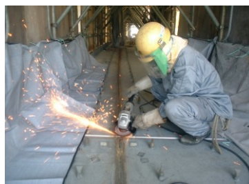
写真-3.3.5 不燃シートの例
