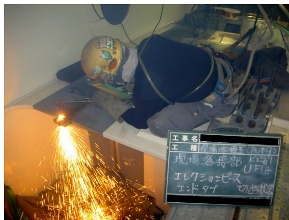
写真-4.3.2 溶断作業
