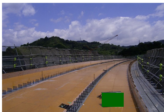
写真-3.3.13 床版型枠の例
