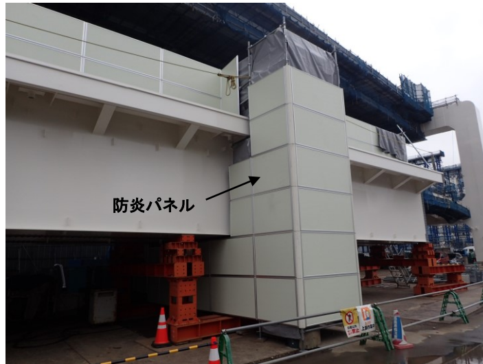
写真-4.3.3 主桁の風防設備設置例
