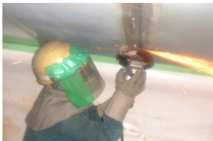
写真-4.2.8 グラインダ作業の例
