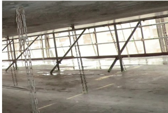
(b) 吊り足場（内部：シート張防護）
