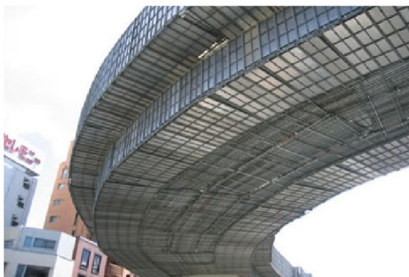
(a) 吊り足場（外観）
