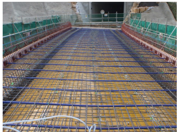
写真-5.1.2 プレグラウト PC 鋼材
