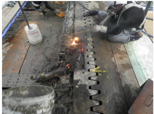
写真-5.3.4 伸縮装置の撤去（溶断）
