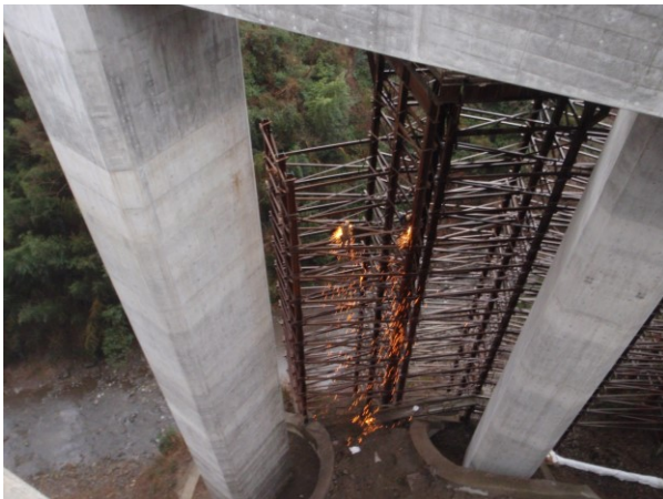
写真-5.3.3 仮栈橋の解体（溶断）
