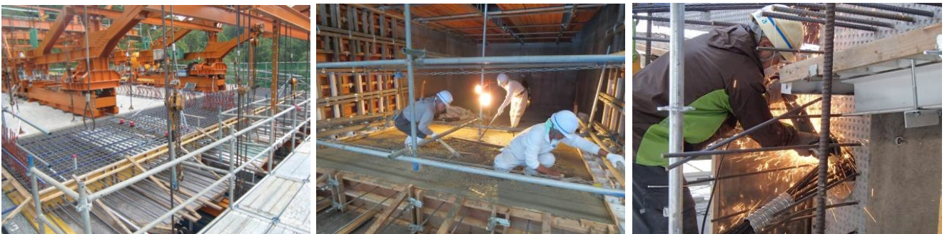
写真-5.2.7 片持架設用移動作業車内での作業例
