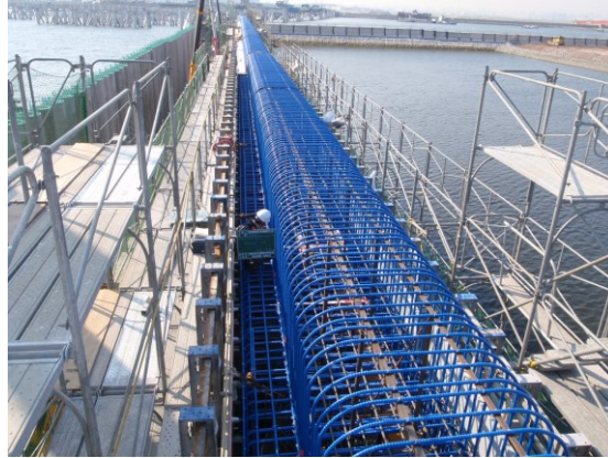
写真-5.1.1 エポキシ樹脂塗装鉄筋
