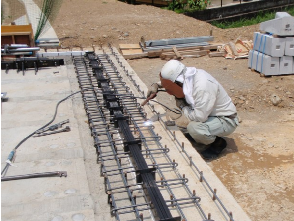
写真-5.3.1 伸縮継手補強筋の溶接
