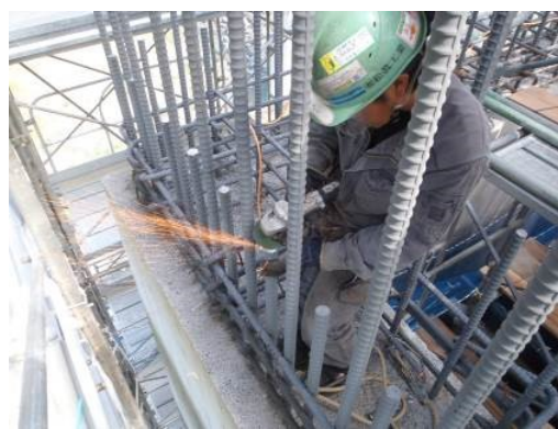
写真-5.2.4 鉄筋圧接前処理
