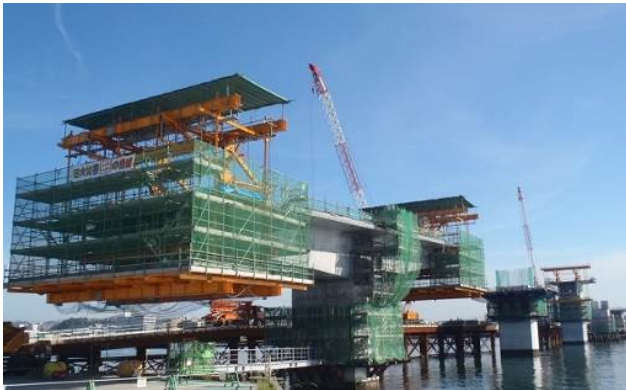
写真-5.2.5 片持架設用移動作業車
