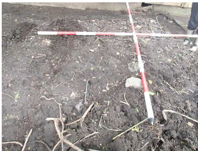
写真 3.4.3 堆積土砂観測地点③の堆積土砂の状況
