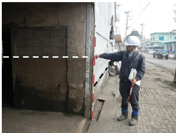
写真 3.6.1 複数の高さの痕跡の例
