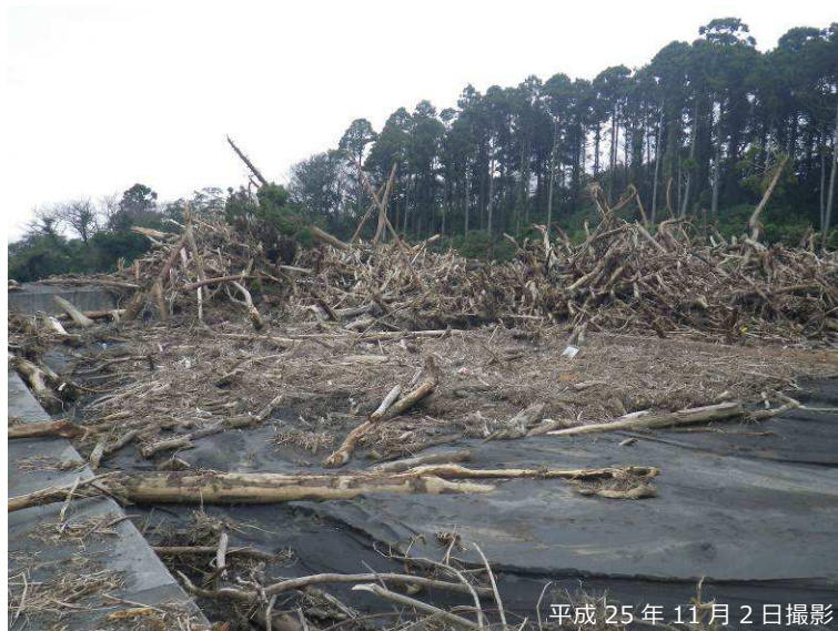
写真 3.2.17 八重沢 P-4 砂防堰堤の土砂・流木捕捉状況
