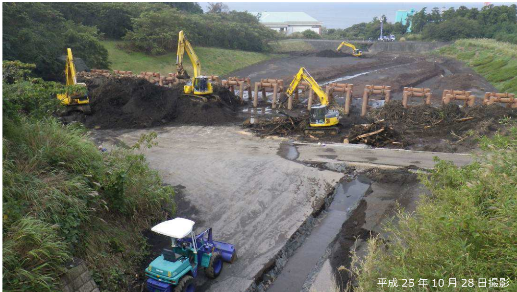
写真 3.2.19 八重沢堆積工（鋼製スリット部）の除石・除木作業状況
