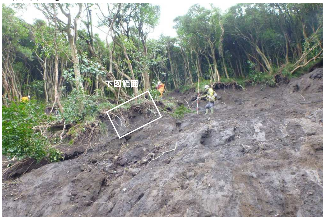
写真 3.1.5 土層観察箇所②の崩壊地全景
