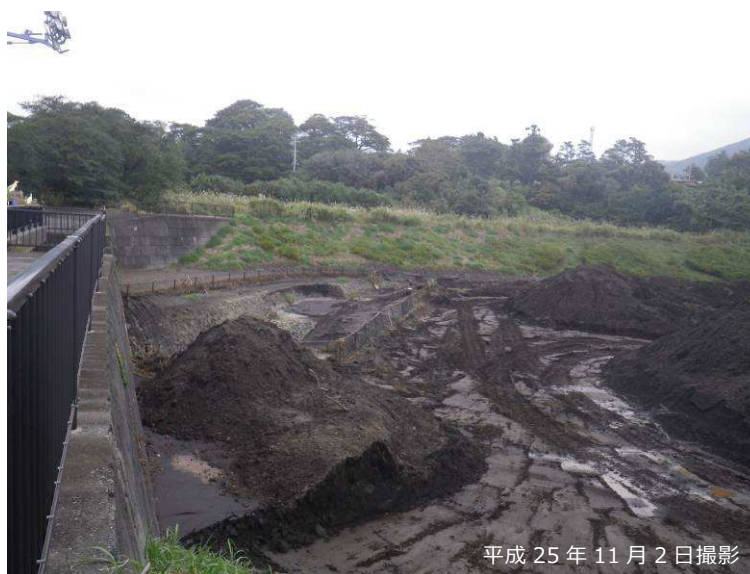
写真 3.2.21 八重沢堆積工の下流端砂防堰堤の水通し部付近
