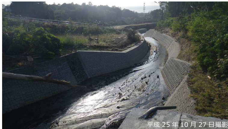
写真 3.2.9 大金沢本川堆積工直下流の溪流保全工の状況
