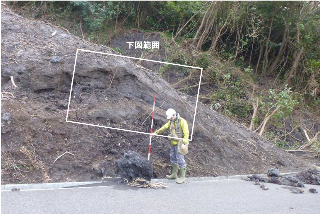
写真 3.1.11 土層観察箇所⑤の崩壊地全景
