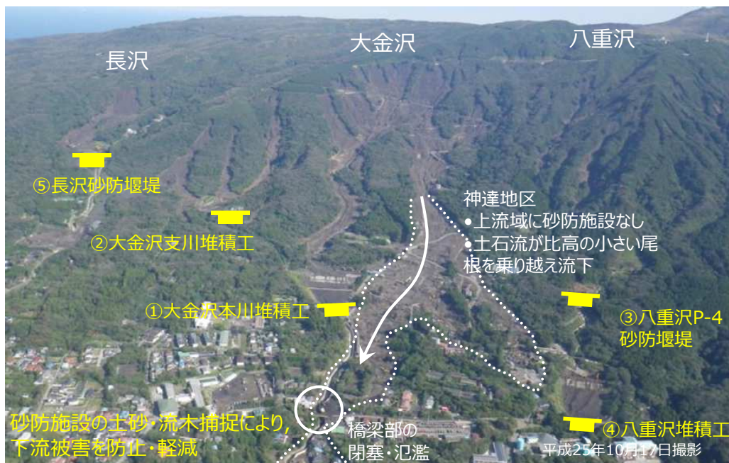
写真 3.2.1 土石流発生状況と砂防施設配置状況
