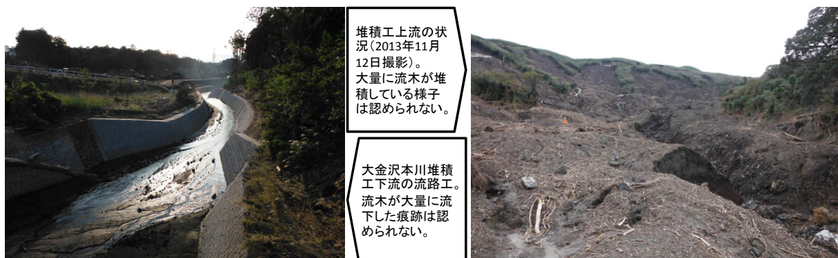
図 3.5.10 左) 大金沢本川堆積工下流の流路工 右) 同堆積工上流側の状況
