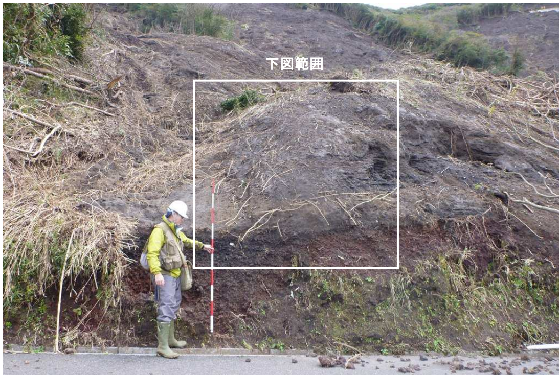
写真 3.1.9 土層観察箇所④の崩壊地全景
