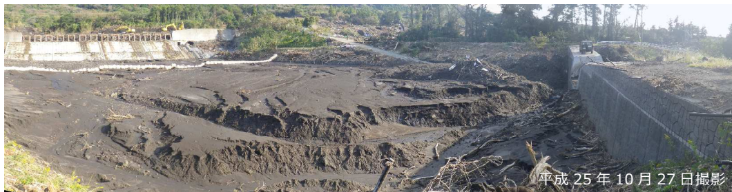
写真 3.2.8 堆積工による細粒土砂捕捉状況
