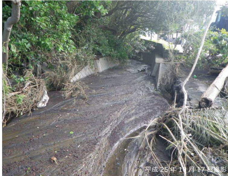
写真 3.2.22 八重沢と周回道路交差点の閉塞状況
