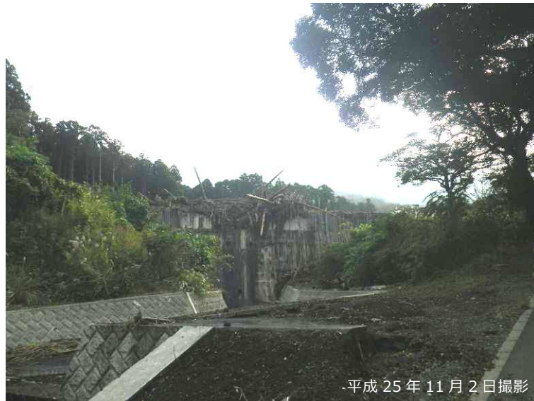
写真 3.2.16 八重沢 P-4 砂防堰堤
