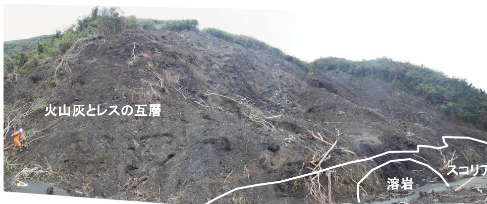
写真 3.1.1 大金沢源頭部の崩壊状況
