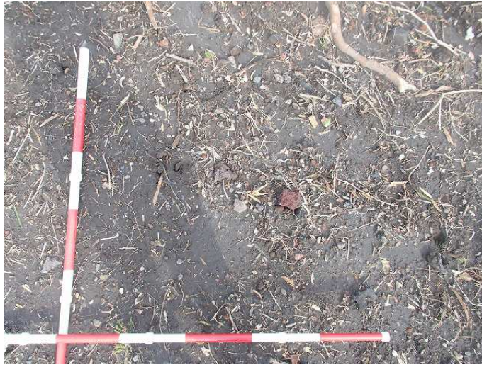
写真 3.4.5 堆積土砂観測地点⑤の堆積土砂の状況
