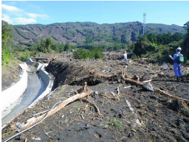
写真 2.3.1 土砂災害発生状況（神達地区）
