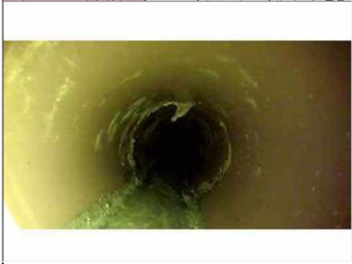
点検カメラ写真番号 | 137 | 浸入水C | 継手部K_④6 | 点検カメラ写真番号 | 139 | 浸入水C、石灰乳C | 継手部K_④11
