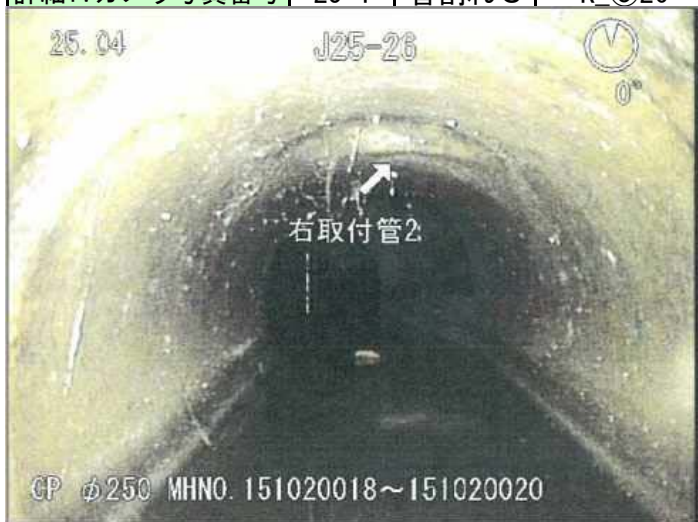
詳細TVカメラ写真番号 | 25-1 | 管割れC | K_㊟26 | 詳細TVカメラ写真番号 | 25-2 | 管割れC | K_㊟26
