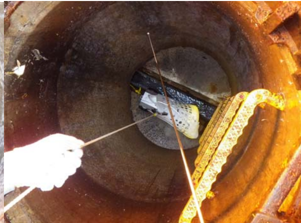
写真 4-9 下流マンホールでのカメラ回収
