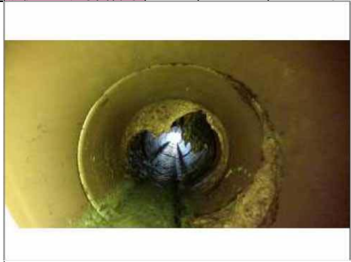
点検カメラ写真番号 | 137 | 浸入水C | 継手部K_④6 | 点検カメラ写真番号 | 139 | 浸入水C、石灰乳C | 継手部K_④11
