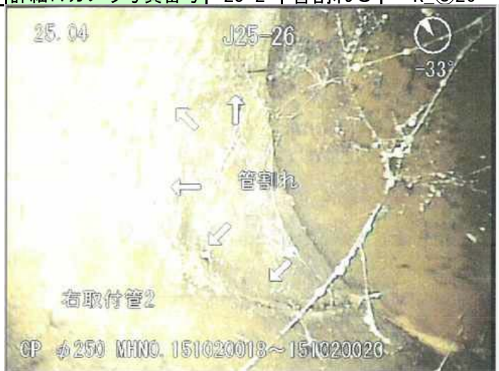
詳細TVカメラ写真番号 | 25-1 | 管割れC | K_㊟26 | 詳細TVカメラ写真番号 | 25-2 | 管割れC | K_㊟26
