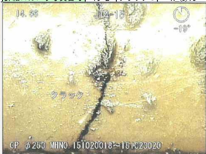
詳細TVカメラ写真番号 | 19-1 | クラックC | K_㊟15 | 詳細TVカメラ写真番号 | 19-2 | クラックC | K_㊟15
