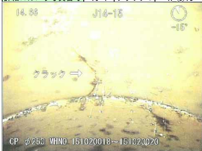
詳細TVカメラ写真番号 | 19-1 | クラックC | K_㊟15 | 詳細TVカメラ写真番号 | 19-2 | クラックC | K_㊟15
