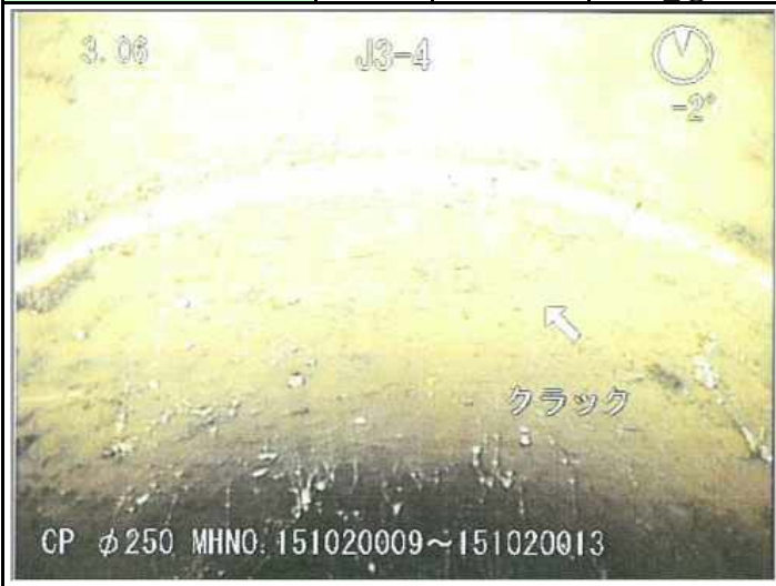
詳細TVカメラ写真番号 | 7-1 | クラックC | K_⑦4 | 詳細TVカメラ写真番号 | 7-2 | クラックC | K_⑦4
