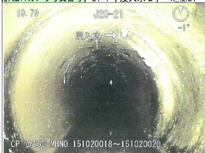
詳細TVカメラ写真番号 | 21-1 | 浸入水C | K_㊟21 | 詳細TVカメラ写真番号 | 21-2 | 浸入水C | K_㊟21
