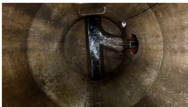
写真 4-6 マンホール内部撮影例
