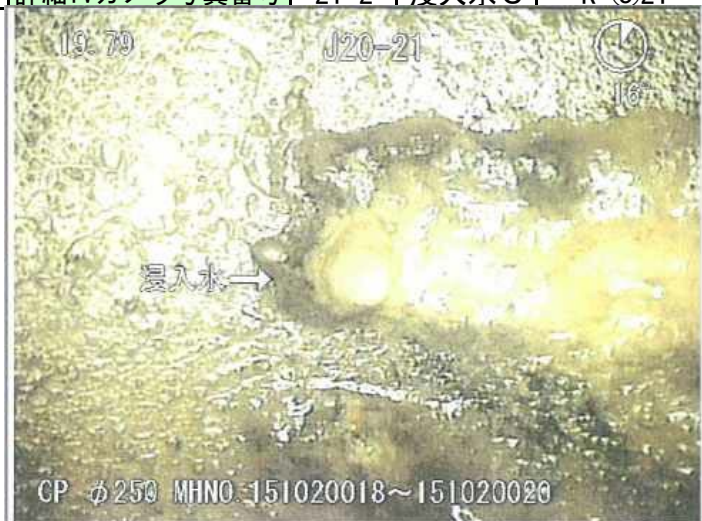
詳細TVカメラ写真番号 | 21-1 | 浸入水C | K_㊟21 | 詳細TVカメラ写真番号 | 21-2 | 浸入水C | K_㊟21
