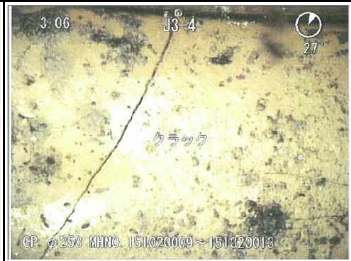
詳細TVカメラ写真番号 | 7-1 | クラックC | K_⑦4 | 詳細TVカメラ写真番号 | 7-2 | クラックC | K_⑦4
