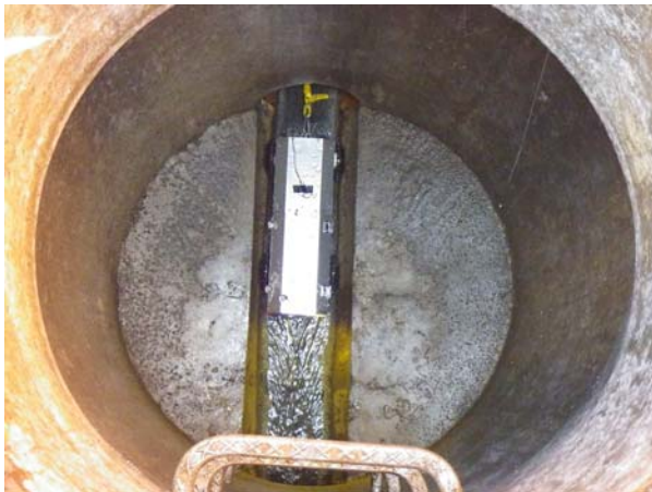
写真 4-8 下流マンホールへのカメラの到達
