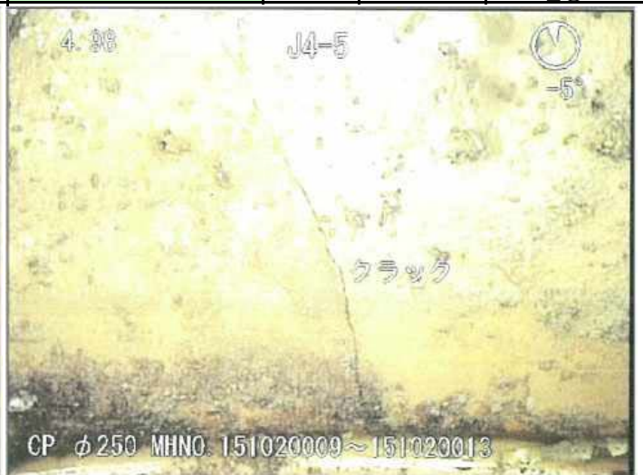
詳細TVカメラ写真番号 | 8-1 | クラックC | K_⑦5 | 詳細TVカメラ写真番号 | 8-2 | クラックC | K_⑦5
