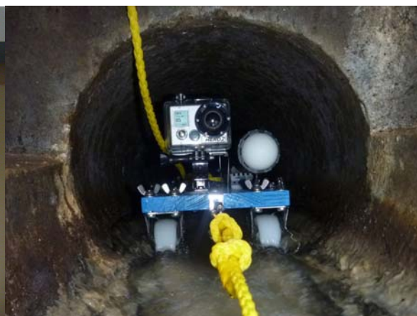
写真 4-2 管きょ内設置状況
