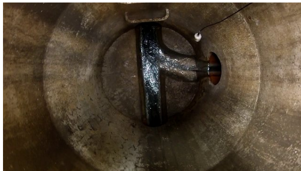
写真 4-6 マンホール内部撮影例
