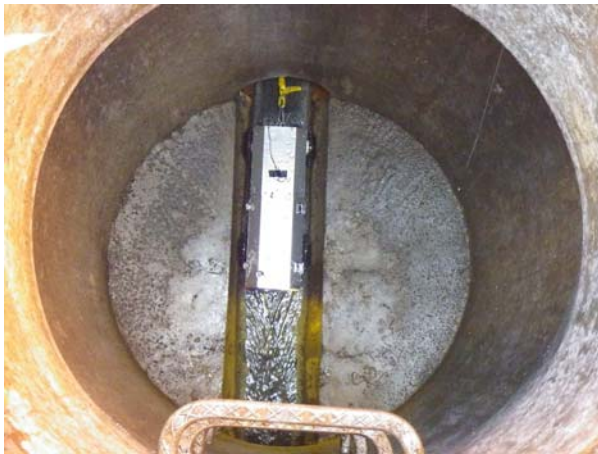
写真 4-8 下流マンホールへのカメラの到達
