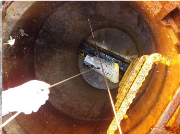
写真 4-9 下流マンホールでのカメラ回収
