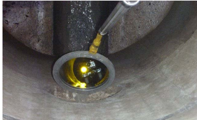
写真 4-7 点検ミラーでのカメラ位置確認状況
