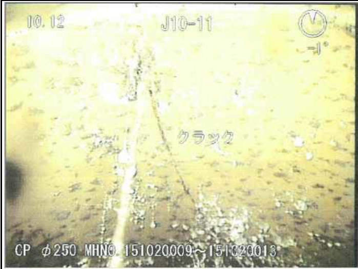
詳細TVカメラ写真番号 | 10-1 | クラックB | K_⑦11 | 詳細TVカメラ写真番号 | 10-2 | クラックB | K_⑦11
