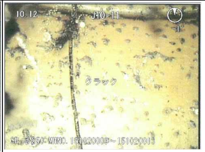
詳細TVカメラ写真番号 | 10-1 | クラックB | K_⑦11 | 詳細TVカメラ写真番号 | 10-2 | クラックB | K_⑦11
