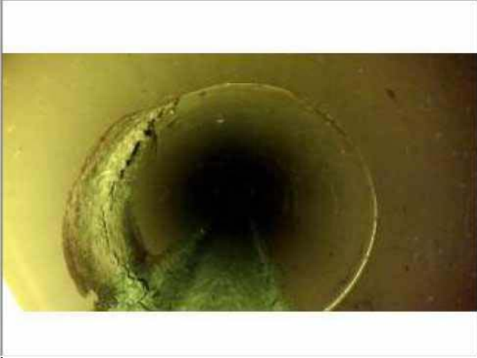
点検カメラ写真番号 | 133 | 浸入水C | 継手部K_④2 | 点検カメラ写真番号 | 134 | 浸入水C | 継手部K_④3
