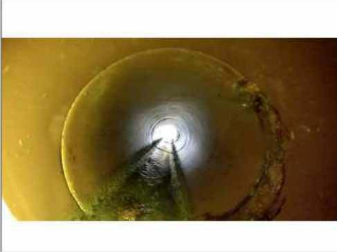
点検カメラ写真番号 | 141 | 浸入水C | 継手部K_④11 | 点検カメラ写真番号 | 143 | 浸入水C | 継手部K_④14
