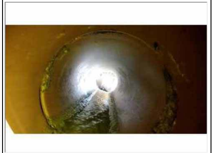
点検カメラ写真番号 | 141 | 浸入水C | 継手部K_④11 | 点検カメラ写真番号 | 143 | 浸入水C | 継手部K_④14
