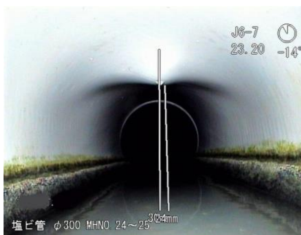
図 3-16 変形の調査状況
