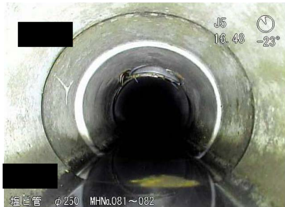
図 2-42 継手ズレの直視画像
