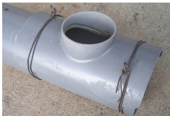
図 3-36 番線による支管の固定
