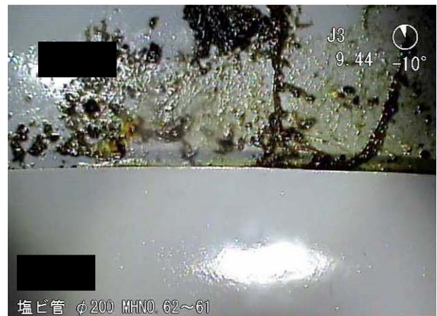
図 2-33 継手ズレの側視画像
