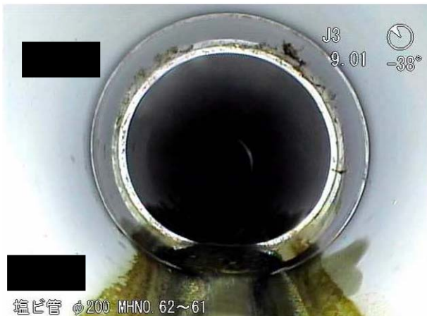
図 2-32 継手ズレの直視画像
