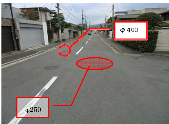
図 2-38 破損箇所の地上の状況
