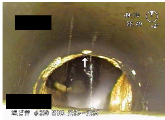
図 2-48 浸入水の直視画像
