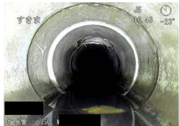
写真－2 継手ズレの事例
