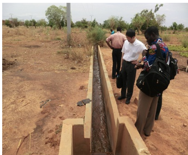
写真3 処理水放流口と農地 ここから流出する処理水を農業利用している。
