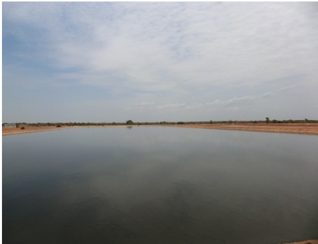
写真2 ラグーン池による下水処理 (ONEA の Kossodo 下水処理場)
