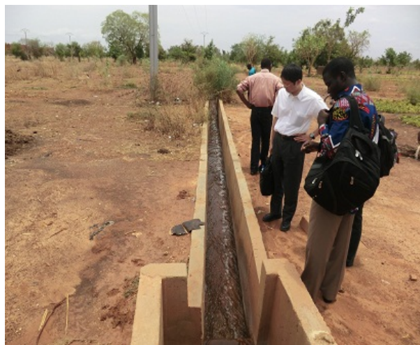
写真3 処理水放流口と農地 ここから流出する処理水を農業利用している。
