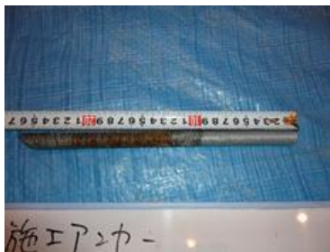
写真-3.2.16 腐食ボルト
