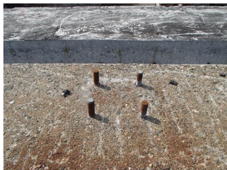
写真-3.2.23 既設あと施工アンカー （非破壊検査対象：22本）
