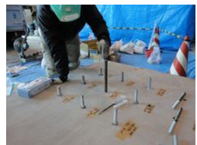
写真-3.2.21 打ち込み量の管理
