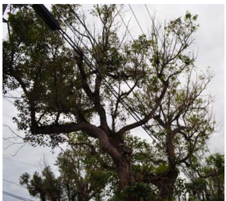
電線との競合状況
