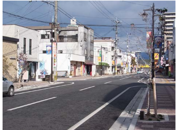
対策後（ハナミズキ区間・平成 26 年 12 月）
