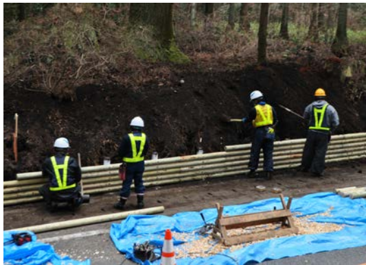
木柵改修状況
