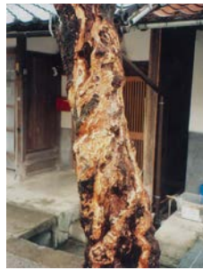
腐朽部削除
