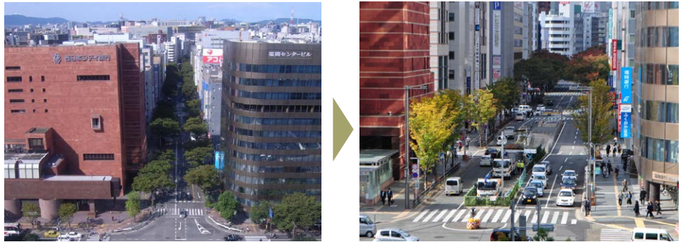
写真-1.8 道路空間の再配分により整備された街路樹
