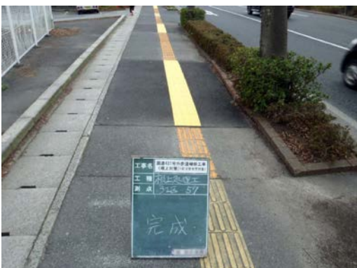
⑤ 対策工完了
