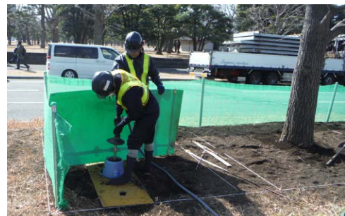
【土壌改良（エアレーション）】
