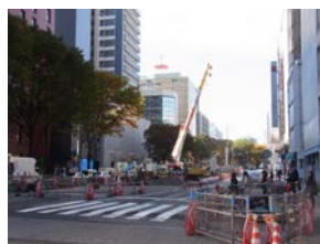
地下鉄整備工事（駅部）
