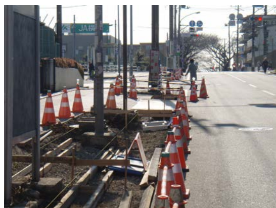
植栽基盤整備
