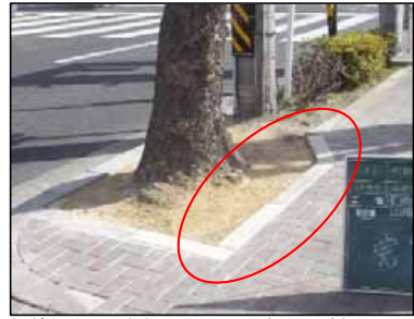
歩道幅員に余裕がある場合に、植栽帯の幅員を広げた施工例
