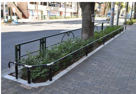
植栽基盤の拡大・駐輪防護柵の設置
