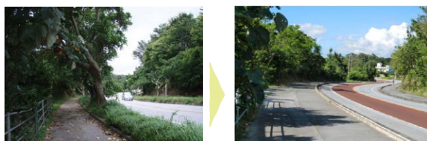
撤去・伐採後の処置
