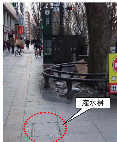
灌水柵の設置
