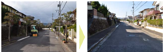
撤去・伐採後の処置
