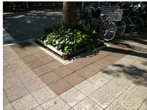
透水性平板の設置状況
