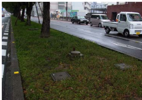
トレンチ式土壌改良施工場所
