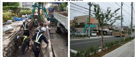
保全・再整備対策工
