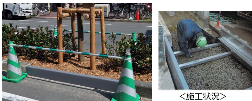
写真-3.2 根上り防止対策の事例：鋼製植栽帯による構造物強化 写真提供：京都市（事例集・再整備No.11）
