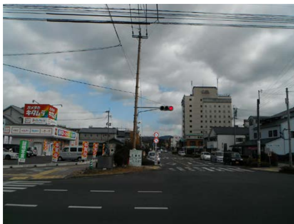
対策施工中（平成 26 年 12 月）
