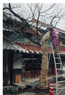
保護材の設置
