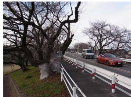
堤防上の道路交通状況
