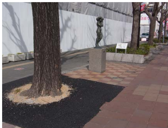
イチョウの根上り対策（透水性アスファルト舗装）
