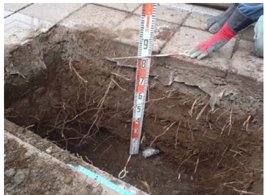
試験掘削状況
