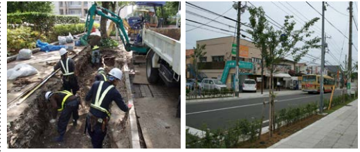
保全・再整備対策工
