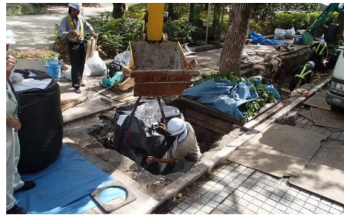
【大規模な土壤改良】 写真提供：江戸川区（事例集・保全No.7）
