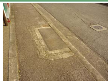
撤去後に被覆された植栽柵
