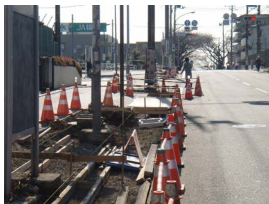
植栽基盤整備
