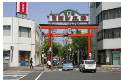
対策前の外観
