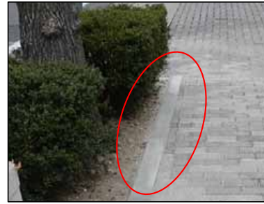
連結プレートIで連結し、一体化を図ることで、ズレ・歪みを防止する。
