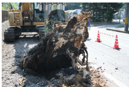
伐採木の腐朽状況
