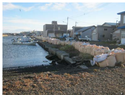
写真-2.6 弥生町③（物揚場背後に積んだ土のう）
