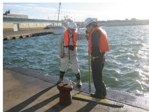
写真-2.3 海岸町③（漁協南側物揚場）
