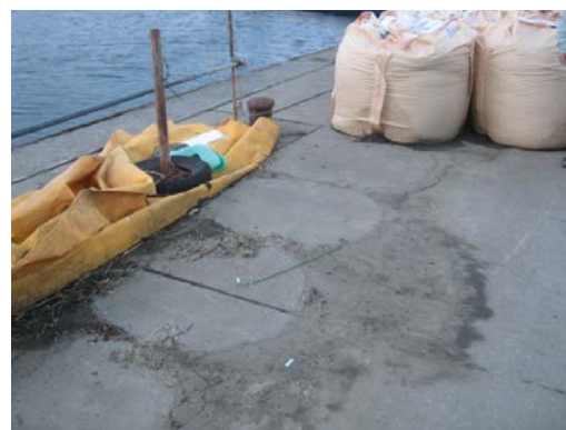
写真-2.7 弥生町④（土のうの設置跡）
