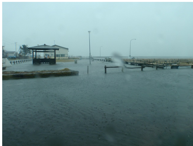
写真-4.6 走古丹漁港における浸水状況
