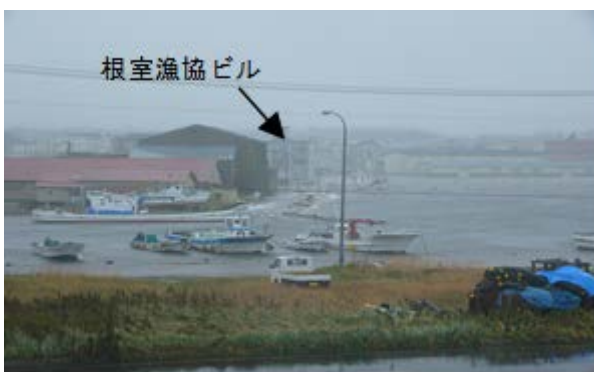
写真-2.1 海岸町①（浸水状況：10/8 10:20a.m.）
