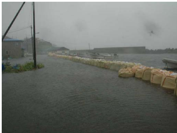
写真-4.4 大型土嚢の設置状況
