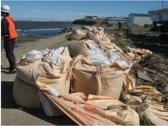
写真-2.14 穂香地区③（護岸に積まれた土のう）
