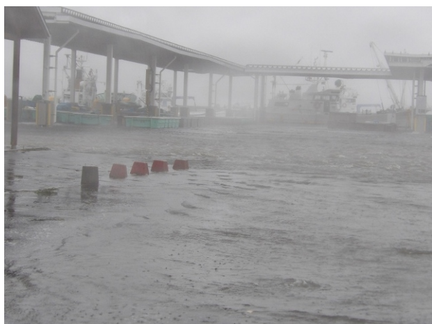
写真-4.8 尾岱沼漁港における浸水状況
