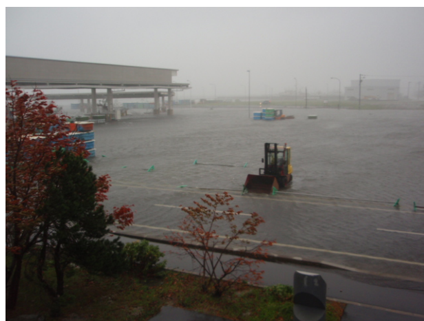
写真-4.9 標津漁港における浸水状況
