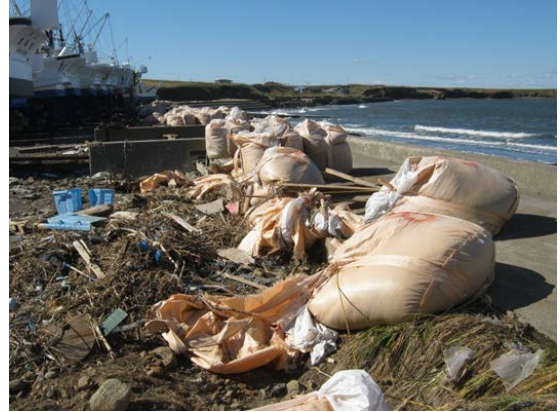
写真-2.15 穂香地区④（護岸に積まれた土のう）
