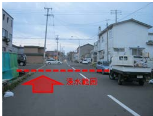
写真-2.5 弥生町②（浸水境界の駐車場（左側））
