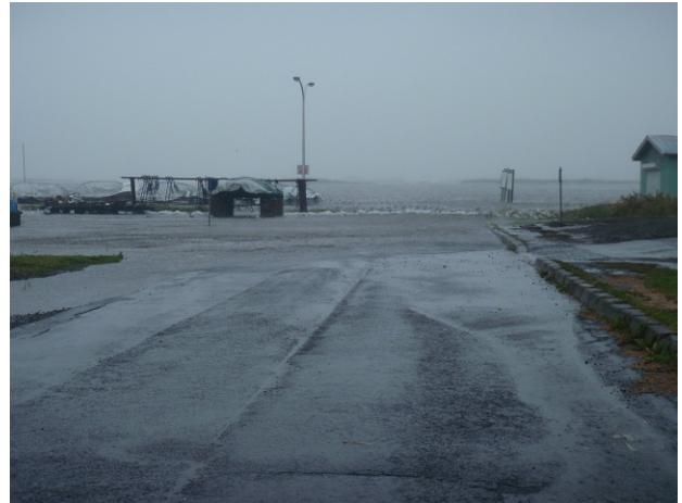
写真-4.7 本別海地区における浸水状況
