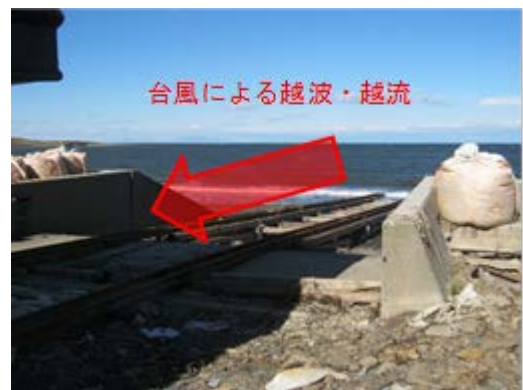
写真-2.13 穂香地区②（造船所斜路）
