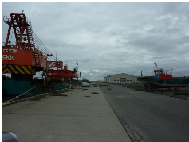
写真-4.1 落石漁港落石地区における浸水後の状況
