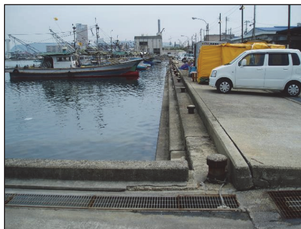
写真-6.11 高松漁港② (防潮壁・陸閘整備前) (台風0416号来襲後)
