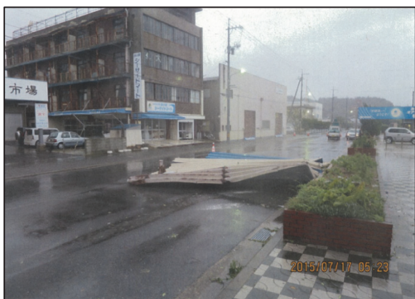
写真-6.2 臨港道路に落下した浮棧橋の屋根 (提供: 宇野港管理事務所)
