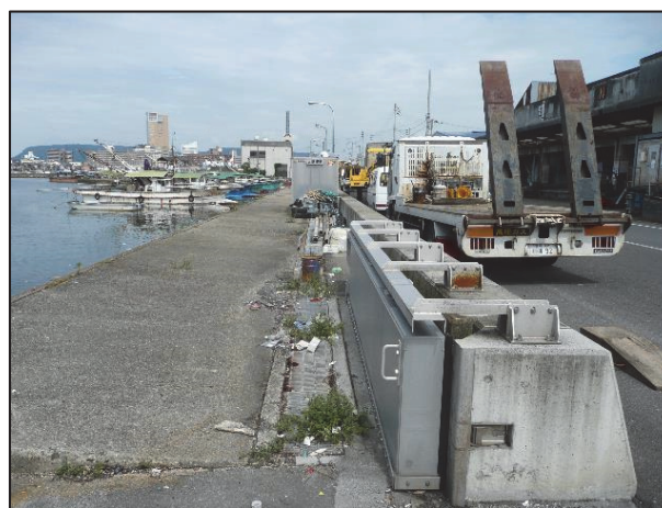
写真-6.12 高松漁港② (防潮壁・陸閘整備後) (台風1511号来襲後)
