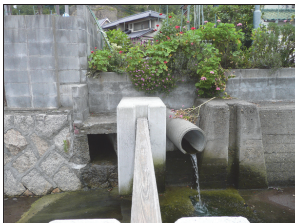
写真-6.5 汐入川上流部の堰板
