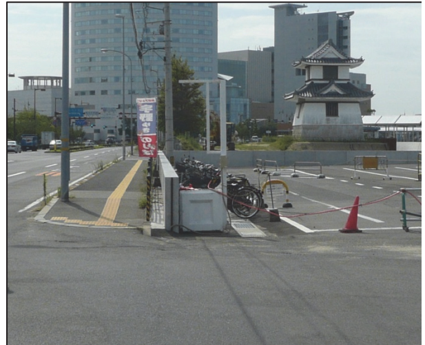
写真-6.8 フェリー乗場背後の防潮壁
