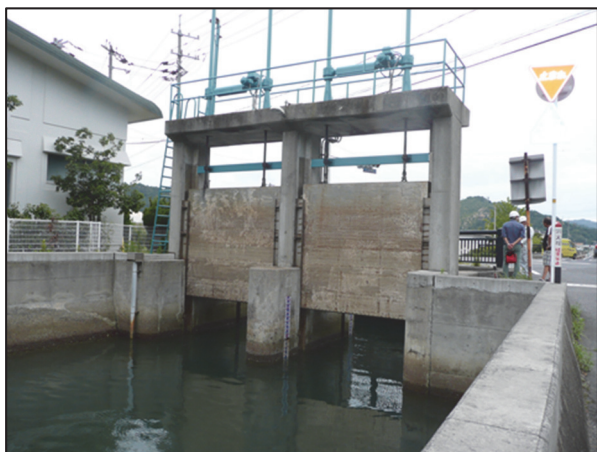
写真-6.3 船越水門 (海側から撮影)
