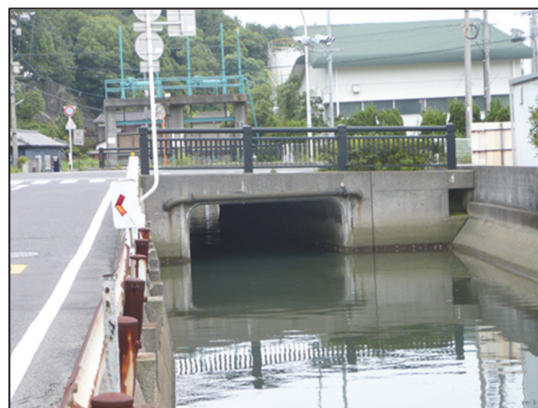
写真-6.4 船越水門 (上流側から撮影)
