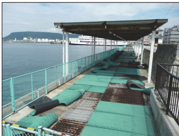
写真-6.9 玉藻第一物揚場
