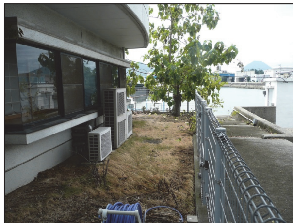
写真-6.13 坂出市港務所の浸水箇所
