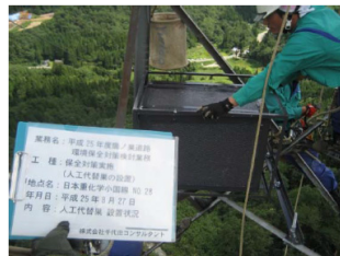
↑設置状況（鉄塔 A）
