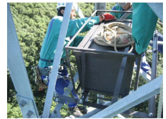
↑設置状況（鉄塔 B）
