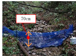
↑ 戻り防止施設として施工した寒冷紗
