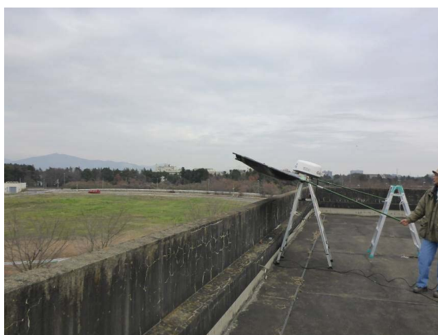
写真 2-4-2 レーダーアンテナおよび電波吸収シート設置状況
