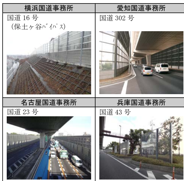
図 2 ヒアリング対象事務所管轄国道の遮音壁
