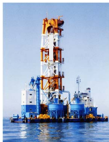
写真-4.9 深層混合処理船の全景
