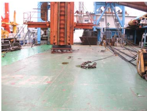
写真-4.6 作業船甲板上の状況
