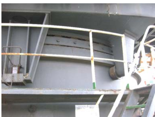
写真-4.8 クレーン旋回台の取付状況
