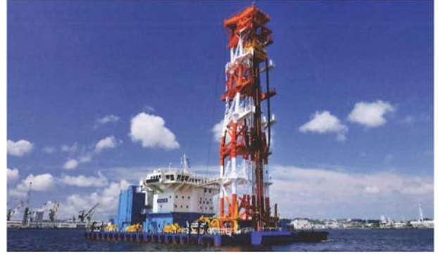
写真-A.13 深層混合処理船 2)
