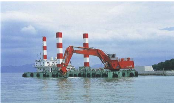
写真-A.3 バックホウ浚渫船 2)
