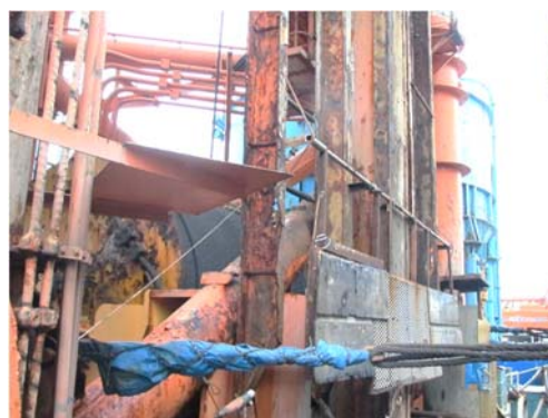
写真-4.10 掘削攪拌装置の状況
