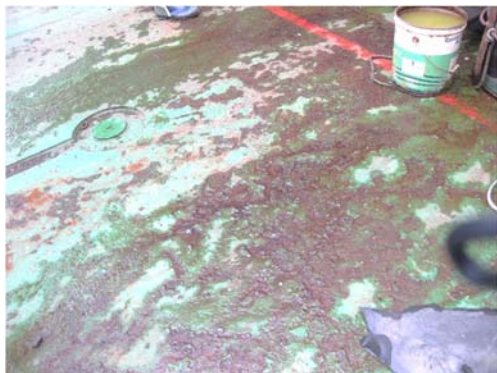
写真-4.11 作業船甲板上的状況
