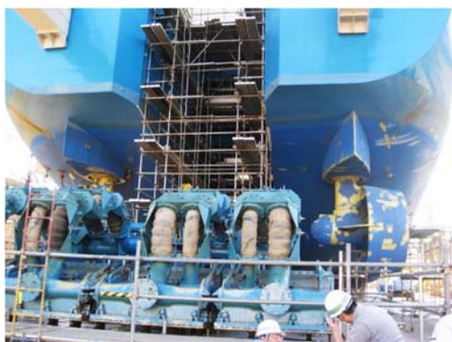
写真-4.3 ドラグヘッドの調査状況
