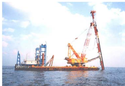
写真-4.5 全旋回式起重機兼杭打船の全景
