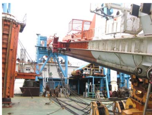
写真-4.7 杭打リーダーの船上格納状況
