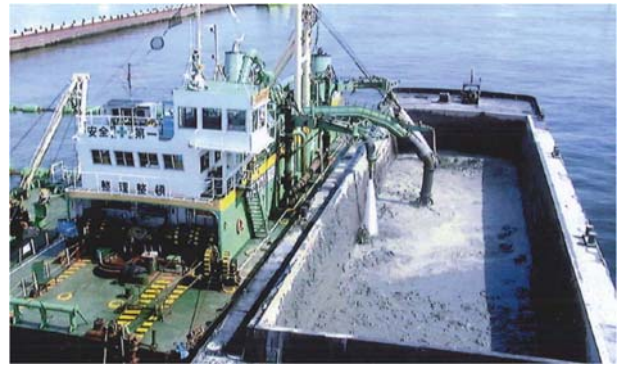
写真-A.5 揚土船 (バージアンローダー船) 2)
