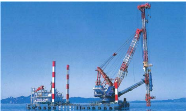
写真-A.12 杭打船 2)
