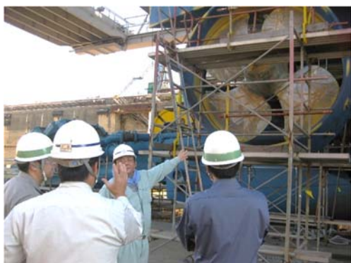
写真-4.2 推進器の調査状況
