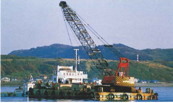
写真-A.9 クレーン付台船 2)
