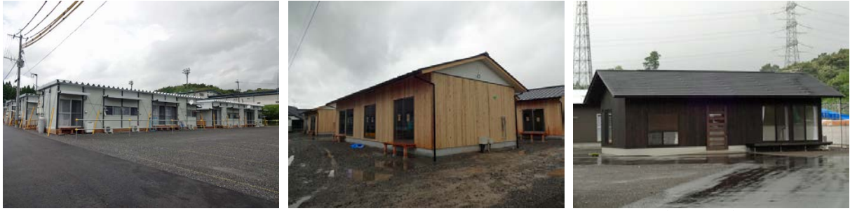
写真 3. 7-1 軽量鉄骨造仮設(甲佐町白旗)・木造仮設(氷川町鹿島)・みんなの家(宇城市当尾)の例
