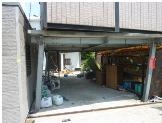
写真 5. 4-40 柱の傾斜
