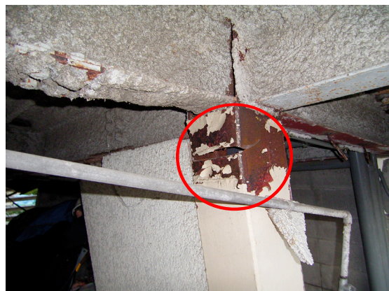
写真 5.4-26 柱の破断
