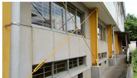
写真 5.4-114 1階の鉛直ブレース
