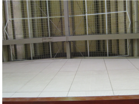
写真 5.4-170 端部付近で変形したバー材（棟部分の形状は台形になっている）
