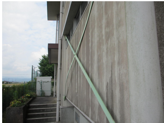
写真 5. 4-127 ブレースのわずかなたわみ
