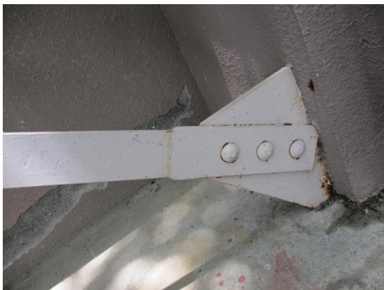
写真 5.4-89 ブレース端接合部分はやや幅広のプレート
