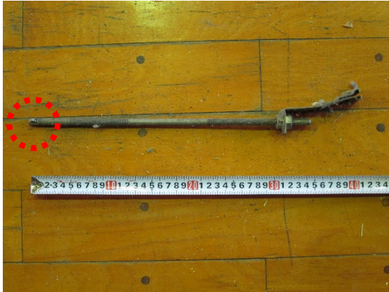
写真 5.4-169 吊り材（円内は溶接痕）
