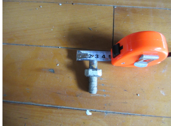
写真 5.4-50 破断した屋根面水平ブレースのボルト
