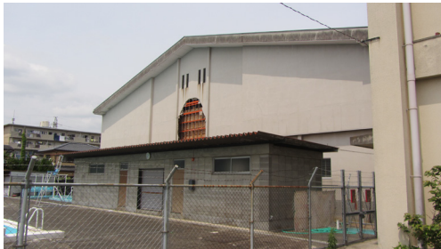
写真 5.4-61 外観（外壁の被害は写真 5.4-69, 5.4-70 参照）
