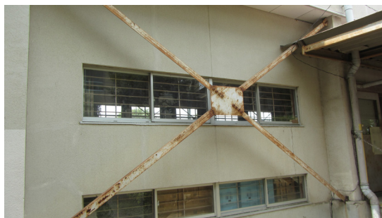
写真 5.4-63 1階鉛直ブレース（被害なし）
