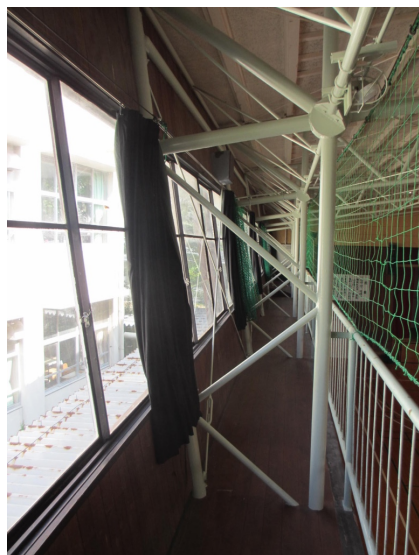
写真 5. 4-149 ラチス形式のフレーム
