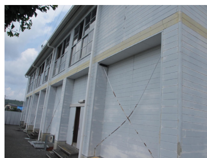
写真 5.4-123 1階のブレースの様子
