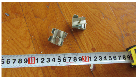
写真 5. 4-145 多数落下していた金具
