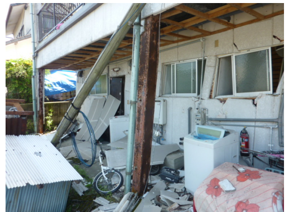
写真 5.4-30 柱の傾斜
