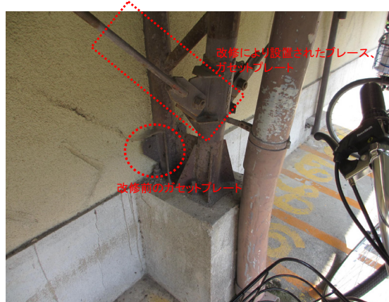
写真 5. 4-148 耐震改修で取り替えられたブレース
