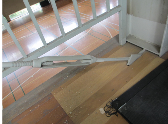
写真 5. 4-44 耐震改修された鉛直ブレース（一部の床板が交換されている）
