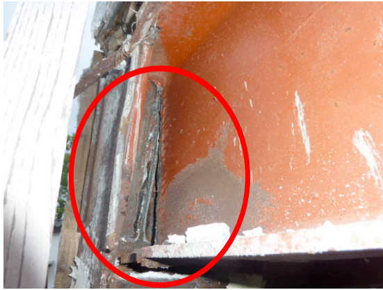
写真 5.4-27 梁端破断
