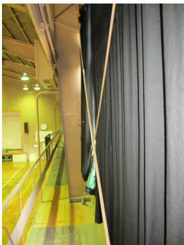
写真 5.4-132 改修で取り替えられたブレースのわずかなたわみ
