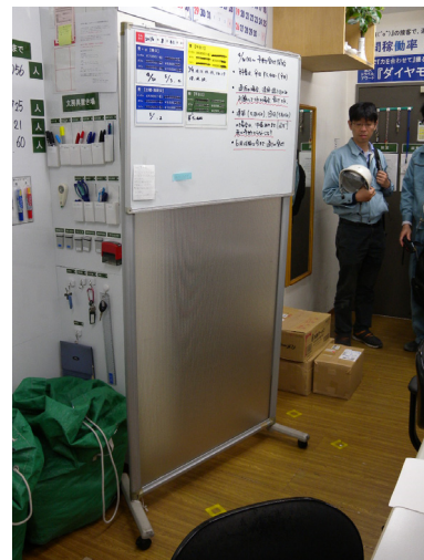
写真 5. 7. 2-32 転倒したパーティション
