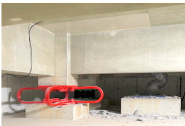
写真 5.7.2-18 鋼材ダンパーと鉛ダンパーの比較
