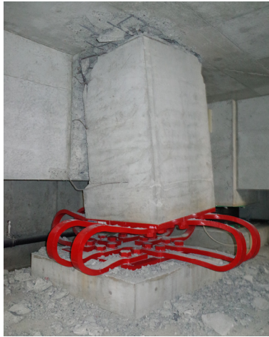
写真 5. 7. 2-51 鋼材ダンパー取付け基部の損傷①（北西部）
