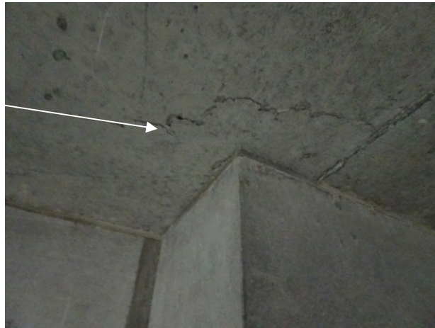
写真 5. 7. 2-55 小型の積層ゴム取付け基部のひび割れ
