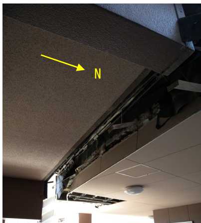
写真 5.7.2-37 渡り廊下エキスパンション部の状況（天井被覆を撤去済み）
