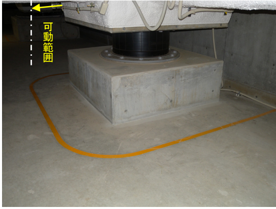
写真 5. 7. 2-61 免震材料及び建築物周辺のマーキング
