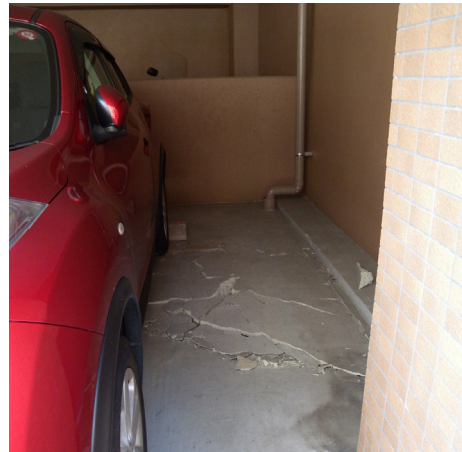
写真 5. 7. 2-53 免震層上面の床スラブの損傷（西側外周部の大梁内側にあたる部分）
