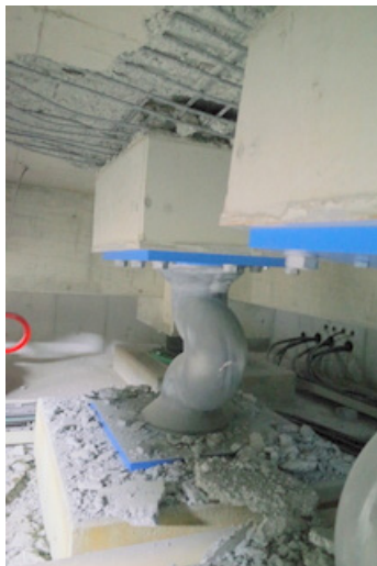
写真 5.7.2-17 鉛ダンパー取付け基部の被害（床スラブの破損）
