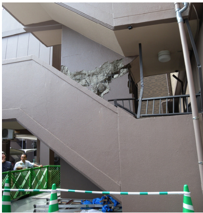
写真 5. 7. 2-40 外付け階段の被害状況② (階段北側)
