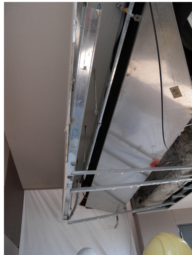
写真 5.7.2-46 渡り廊下エキスパンション部の状況①（天井被覆を撤去済み）
