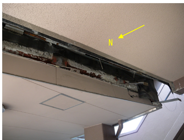
写真 5.7.2-37 渡り廊下エキスパンション部の状況（天井被覆を撤去済み）
