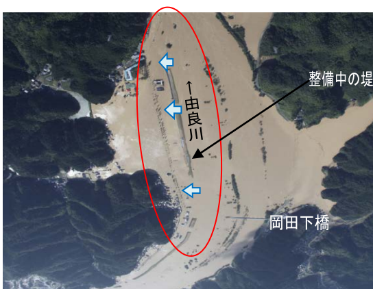
写真-3.2.29 志高地区の航空写真 (近畿地方整備局提供、9月16日15:14撮影)
