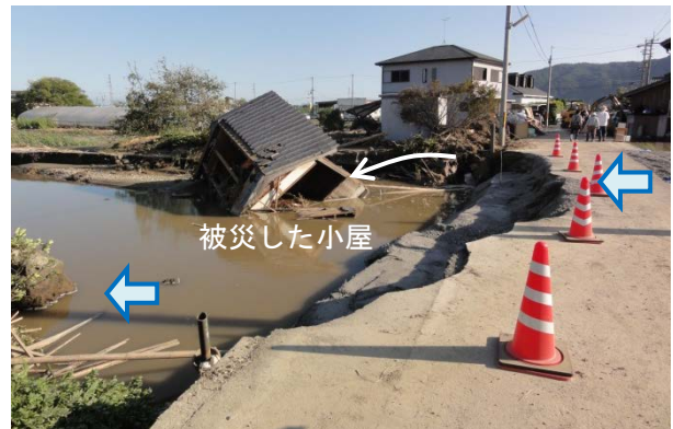
写真-3.2.15 建物の倒壊 (9月18日調査)
