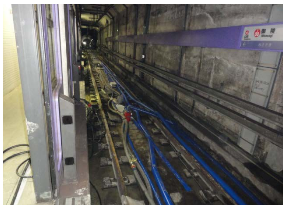
写真-3.2.36 京都市営地下鉄東西線御陵駅～山科駅間の排水作業（9 月 18 日：御陵駅構内より許可を得て撮影）
