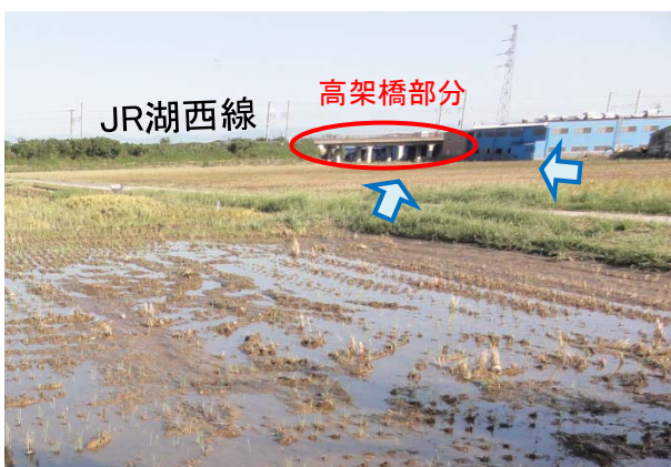
写真-3.2.6 JR湖西線の高架橋部分（9月18日調査）
