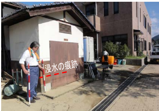
写真-3.2.28 大江支所周辺の浸水痕跡高約60cm (9月19日調査)
