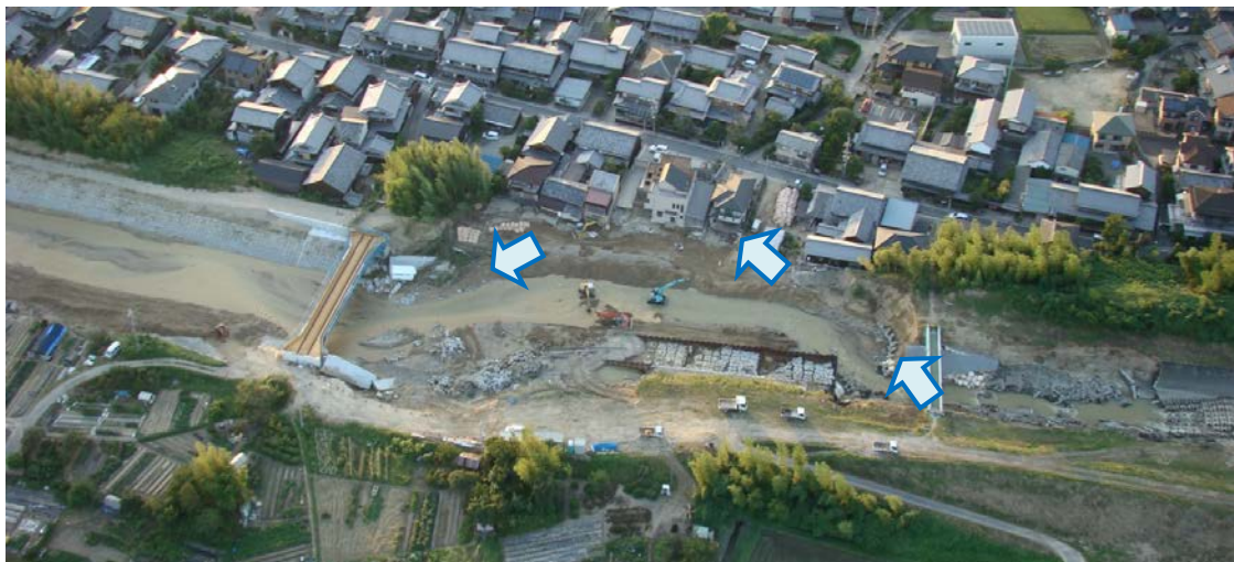
写真-3.2.1 金勝川目川地区の決壊後の状況（滋賀県提供、9月18日撮影）
