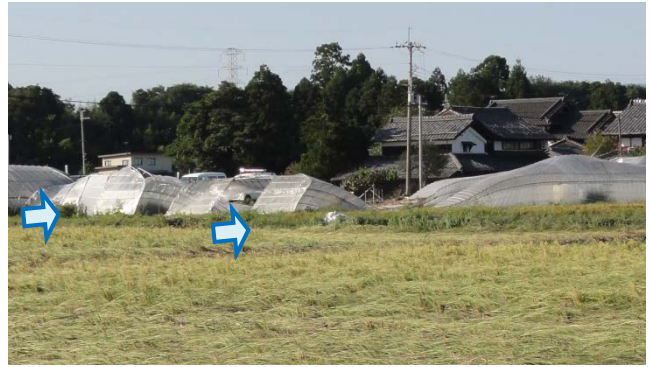
写真-3.2.11 ビニールハウスの損壊 (9月18日調査)
