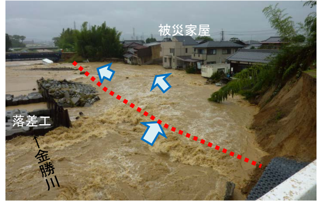
写真-3.2.3 堤防の決壊と洪水流 (16日9時頃)(滋賀県提供)
