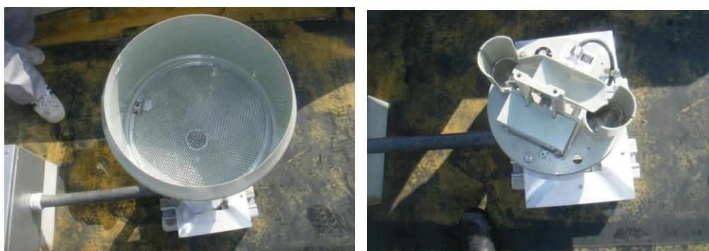
機器清掃後状況／広瀬小学校
