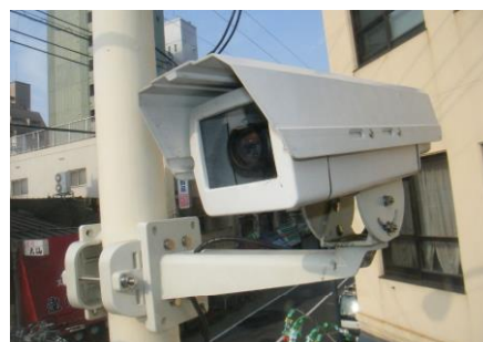
図 5-24 光給電（浸水状況撮影）カメラの点検状況
