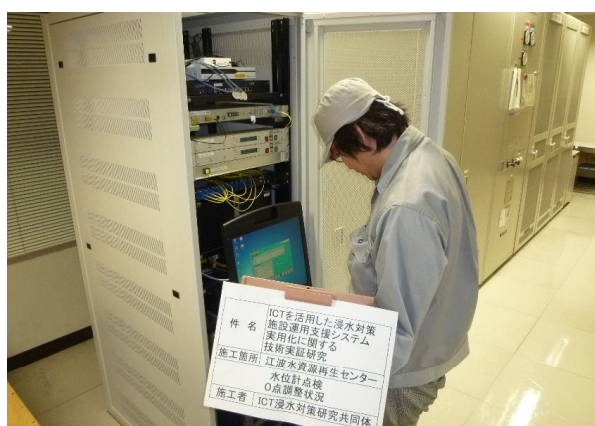
小型光水位計点検／0点調整作業
