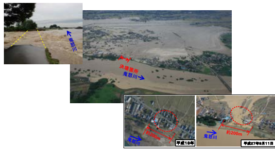
決壊箇所周辺では、氾濫流により多くの家屋が倒壊・流失 6
