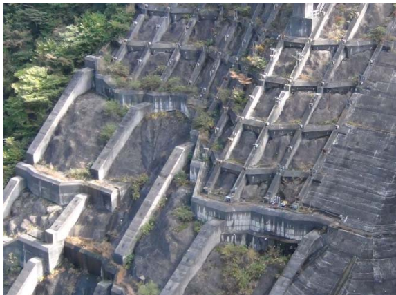
図 1.2 堤体周辺岩盤でのアンカー施工事例(1)
