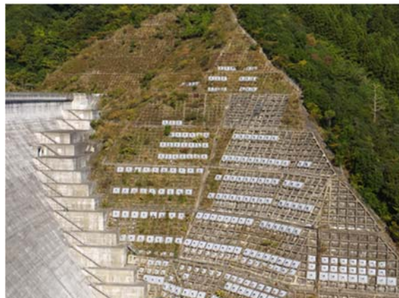
図 1.3 堤体周辺岩盤でのアンカー施工事例(2) 7)
