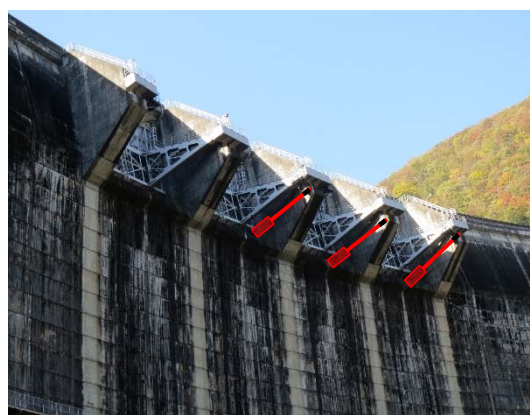
図 1.6 ゲート固定用アンカー施工事例(2) (写真の一部に加筆)
