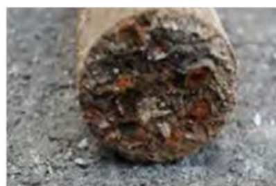
遅れ破壊により破断した鋼棒の破断面 (刃物で切断したような破断形状となる)
