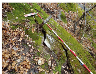
図-6 変状事例（吹付けモルタル-亀裂・空洞化）
