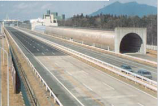
実大トンネル実験施設
