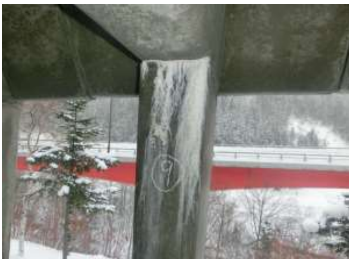
写真番号 S-8.1.5 説明 谷側柱に漏水・遊離石灰が生じた例。
