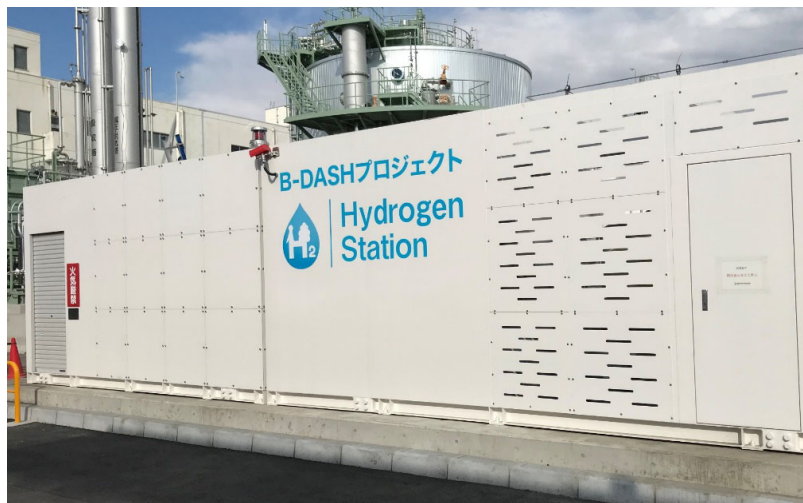
写真 2-7 水素供給装置
