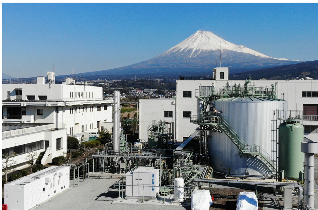
写真2-1 本技術の実証設備全景
