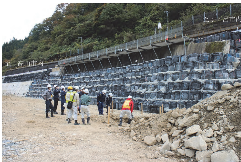
写真-4.1.3 擁壁基礎の支持層を確認するための試掘状況（10月28日撮影）
