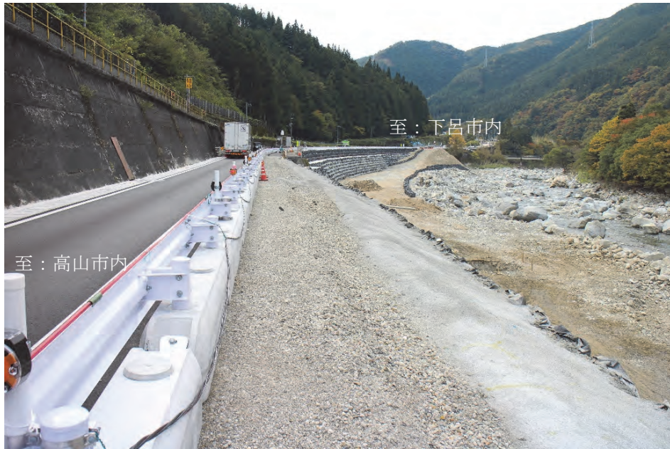
写真-4.1.6 仮復旧路面および大型土のうの天端の状況（10月28日撮影）
