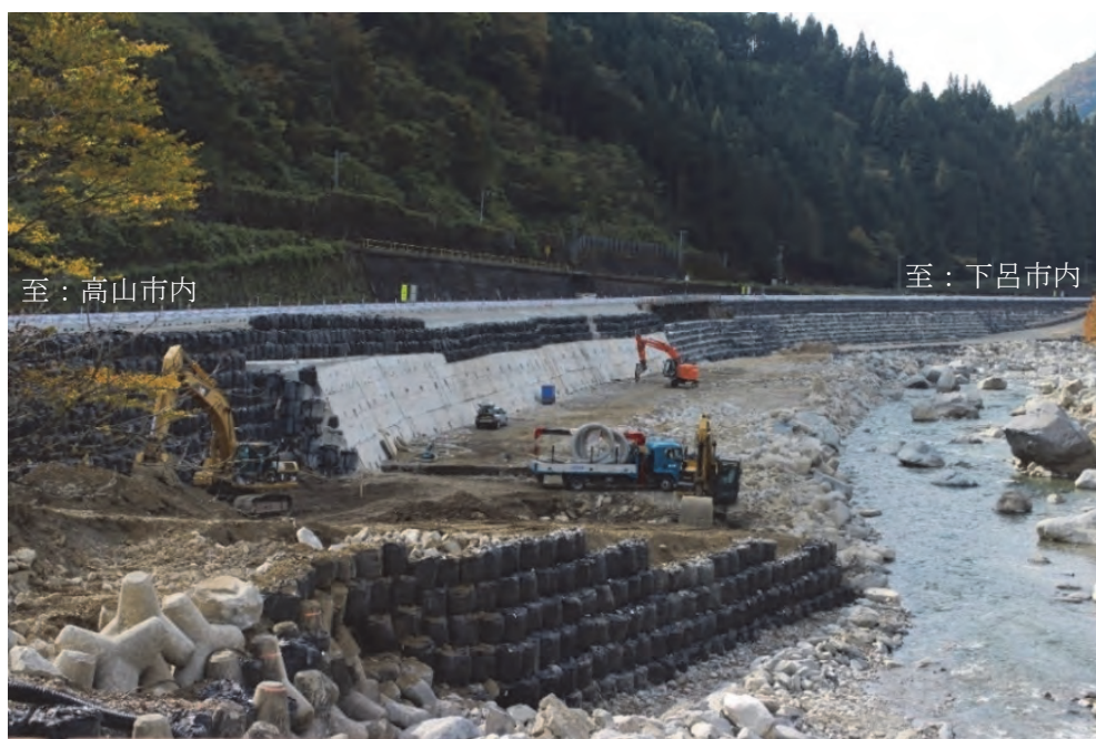
写真-4.1.2 本復旧に向けた仮設盛土の整備状況（10月28日撮影）
