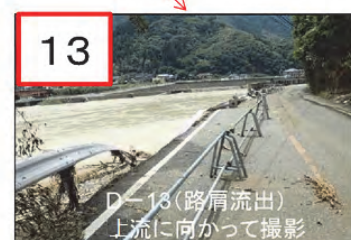
写真-4.1.22 被災当時の状況 2) に被災箇所等の情報を加筆 (被災写真はTEC-FORCE7月8日撮影)
