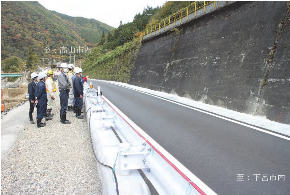
写真-4.1.7 JR 高山本線擁壁の調査状況（10月28日撮影）
