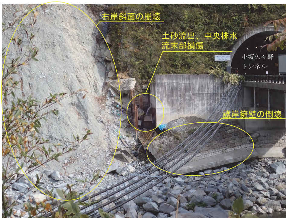
写真-4.1.8 小坂久々野トンネル坑口周辺部 (10月28日撮影)
