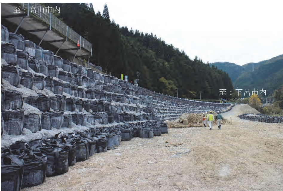
写真-4.1.5 下呂市側応急復旧状況（10月28日撮影）
