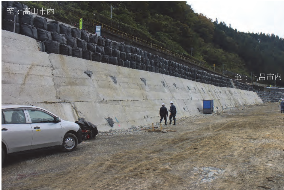
写真-4.1.4 高山市側応急復旧状況（10月28日撮影）
