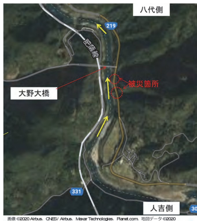
写真-4.1.9 大野大橋付近の国道219号 被災箇所位置図 2) に被災箇所等の情報を加筆
