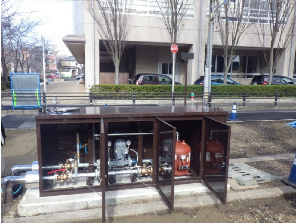
写真 V-5 制御盤一体型バルブボックス写真
