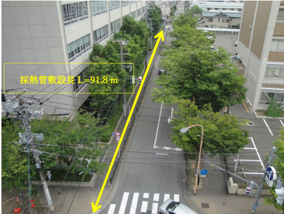
写真 V-3 採熱範囲地上写真（隣接ビル屋上より）※写真は施工前
