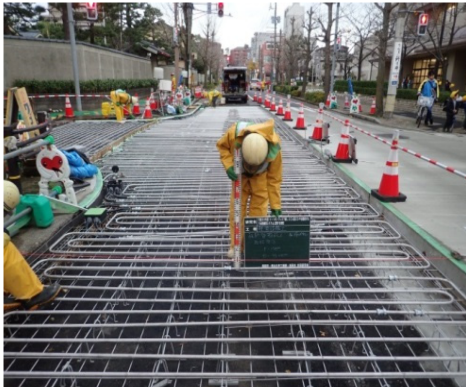
写真 V-2 放熱パネル※コンクリート打設前
