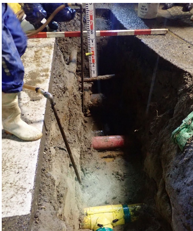
写真 3-2 地下埋設物の試掘調査の一例※詳細設計時や本施工前に行う
