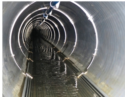
写真 4-2 採熱管固定状況
