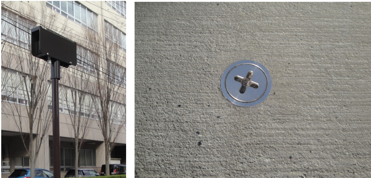
写真 2-5 実証研究施設の制御センサの例（左：降雪センサ本体、右：温度センサ※筐体） ※温度センサは、筐体に内蔵されて舗装面に設置
