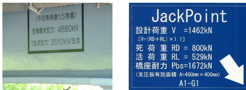
写真-2.1.1 ジャッキアップポイント等表示の例
