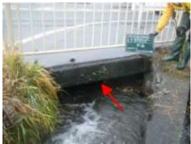
(d) 狭隘な桁下空間
