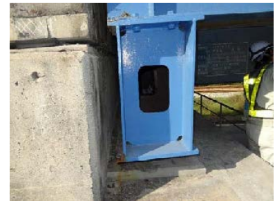
(i) 桁端部の点検開口部
