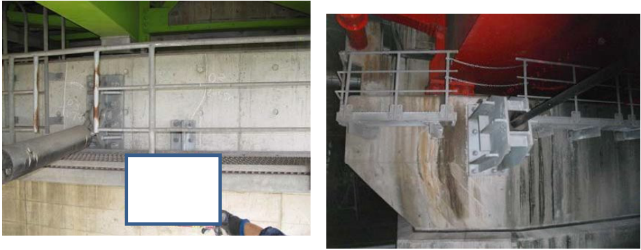
写真-2 検査路と落橋防止装置との取合い
