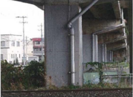
写真-1 排水管のズレ事例
