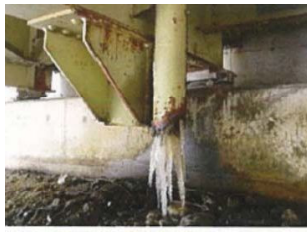
写真-4 排水管流末処理の不良事例
