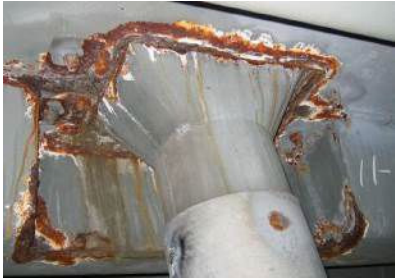
図-1 排水柵周辺の損傷状況
