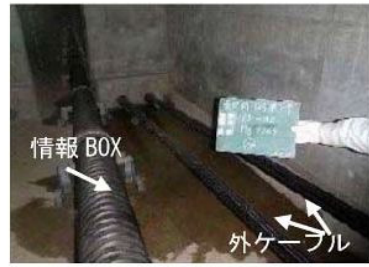
写真-4 添架物による箱桁内部の排水
