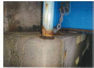
写真-4 排水管流末処理の不良事例
