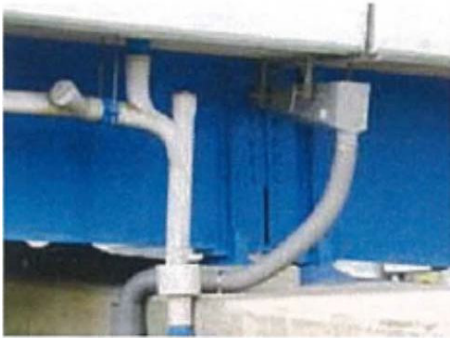
図-1 支持金具と排水管接続部の位置関係
