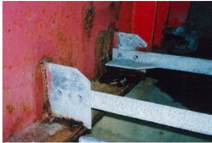
写真-1 添架物の支持金具の例
