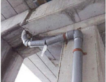
写真-1 排水管のズレ事例
