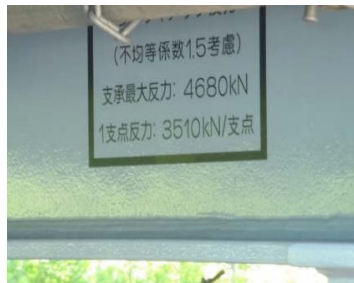
図-4 ジャッキアップポイント等表示の例
