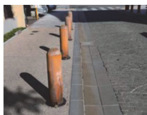
写真-1 使い勝手に配慮した横断構成：セミフラット形式の歩道（左）と着脱式のボラード（右） 【福岡市承天寺通り】（※市提供）
