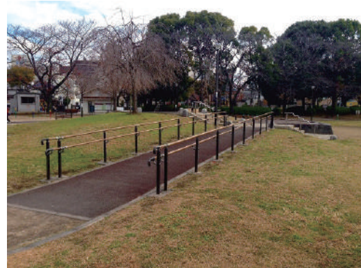
スロープに設置された手摺
