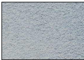
健全な状態の薄付け仕上塗材の画像例
