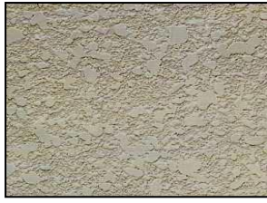
健全な状態の複層仕上塗材の画像例
